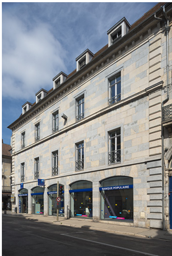
Façade rue de la République, vue de trois quarts droite. 25, Besançon, 9 rue de la République
