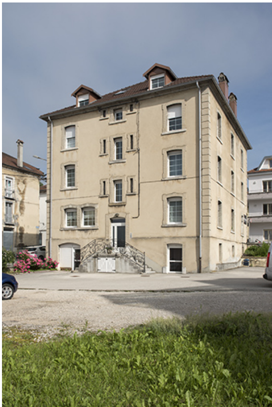
Façades sud (entrée, sur cour) et est. 25, Morteau, 8 rue Gonsalve Pertusier
