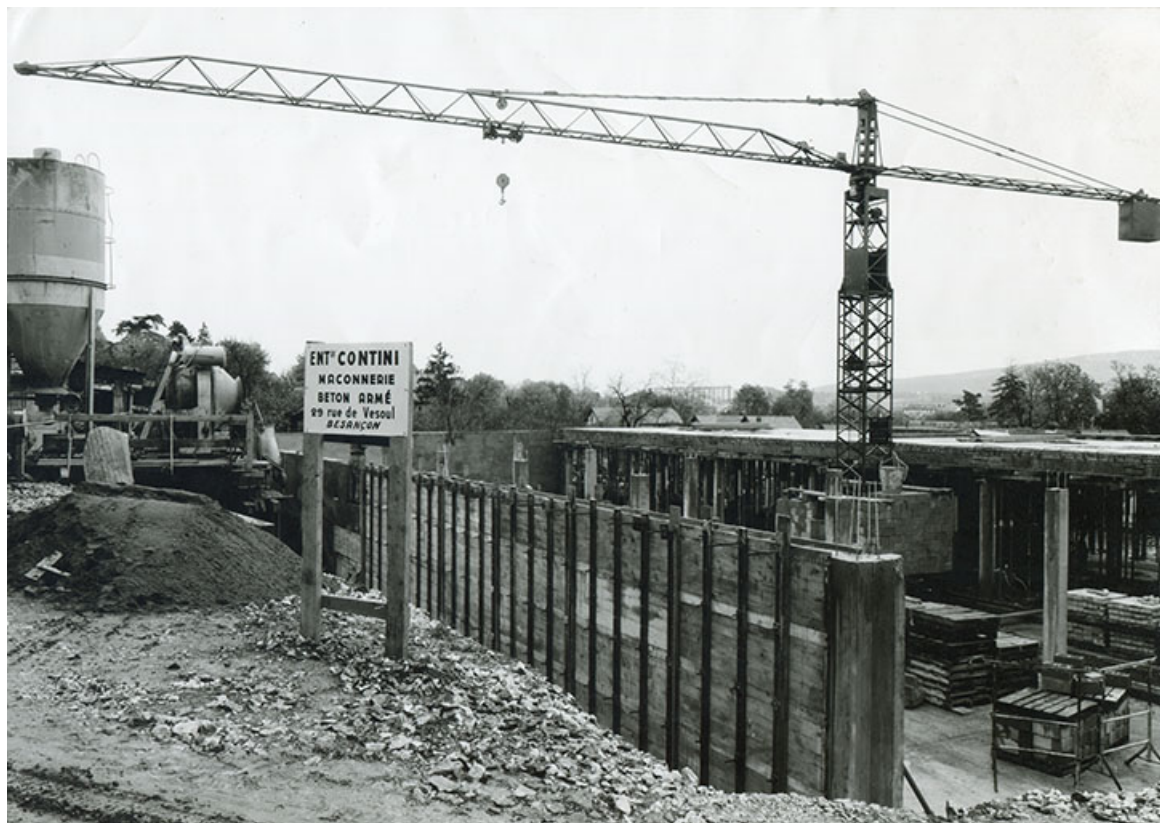
Chantier de construction de l'usine B, fotogr., 1961.
