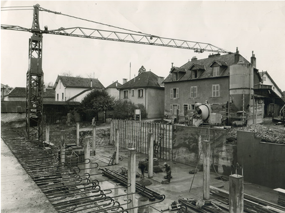
Chantier de construction de l'usine B, fotogr., 1961. 25, Besançon, 5, 12 rue du Tunnel
