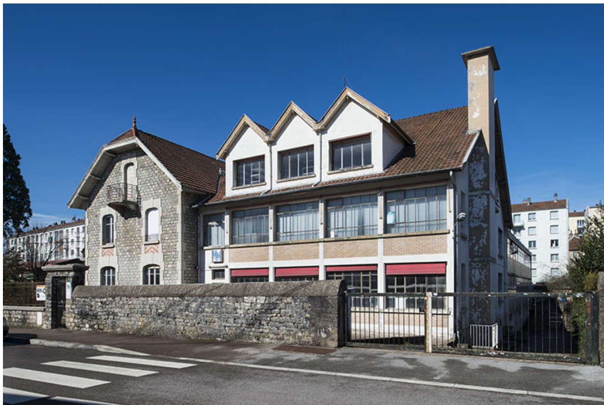
Le logement et l'atelier sur rue, depuis le sud-est.
