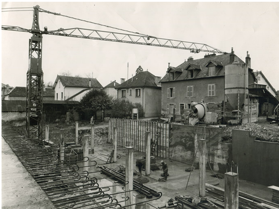
Chantier de construction de l'usine B, fotogr., 1961.
