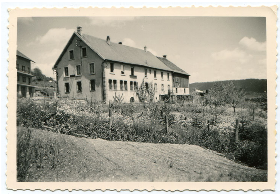
[Vue d'ensemble de la fonderie, depuis le sud-ouest], milieu 20e siècle [entre 1933 et 1967]. 25, Les Fins, 4 route de Morteau
