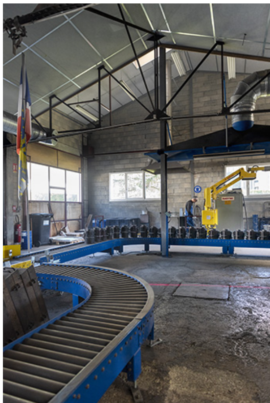
Intérieur de l'atelier au rez-de-chaussée : convoyeur avec, au fond, la zone de coulée. 25, Les Fins, 4 route de Morteau
