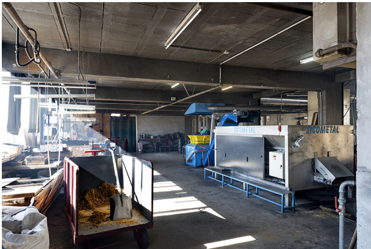
Intérieur de l'atelier au rez-de-chaussée : moulage à gauche, démoulage à droite. 25, Les Fins, 4 route de Morteau
