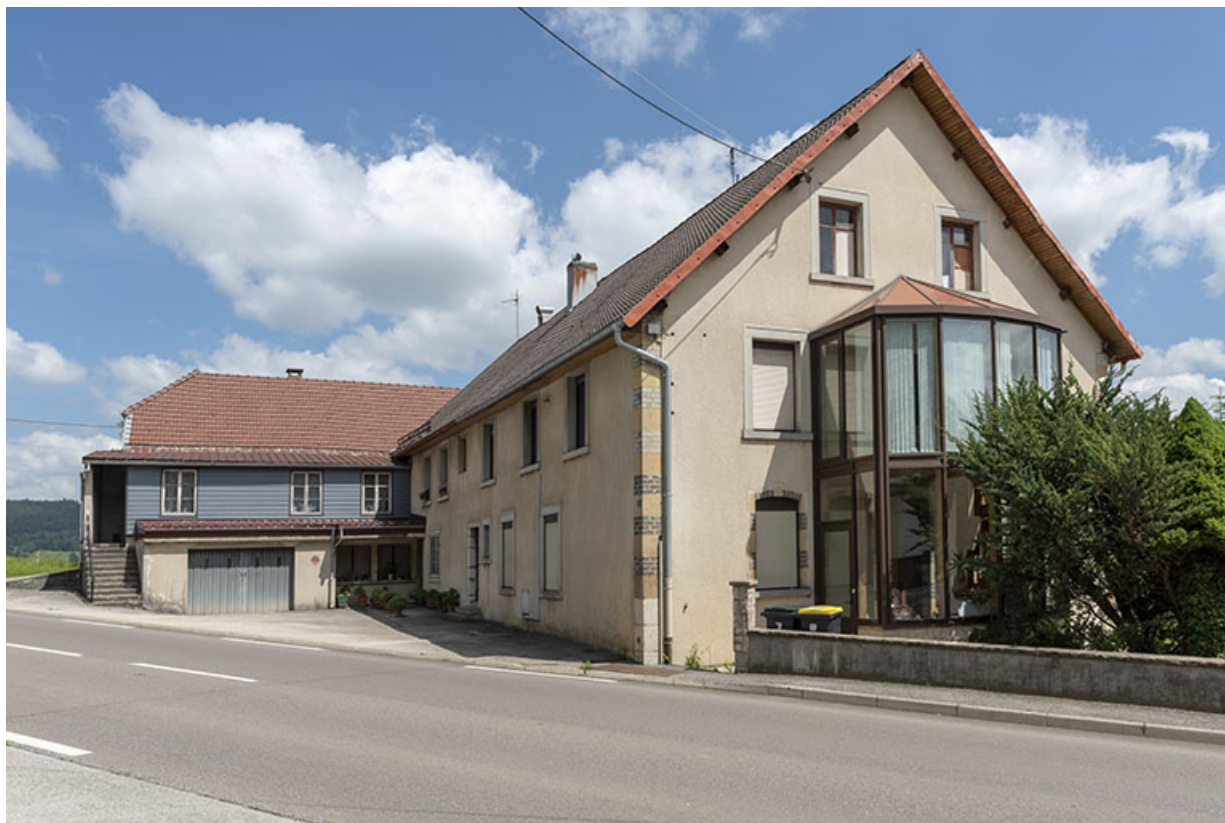
Ancien site : vue d'ensemble depuis l'ouest. 25, Les Fins, 4 route de Morteau
