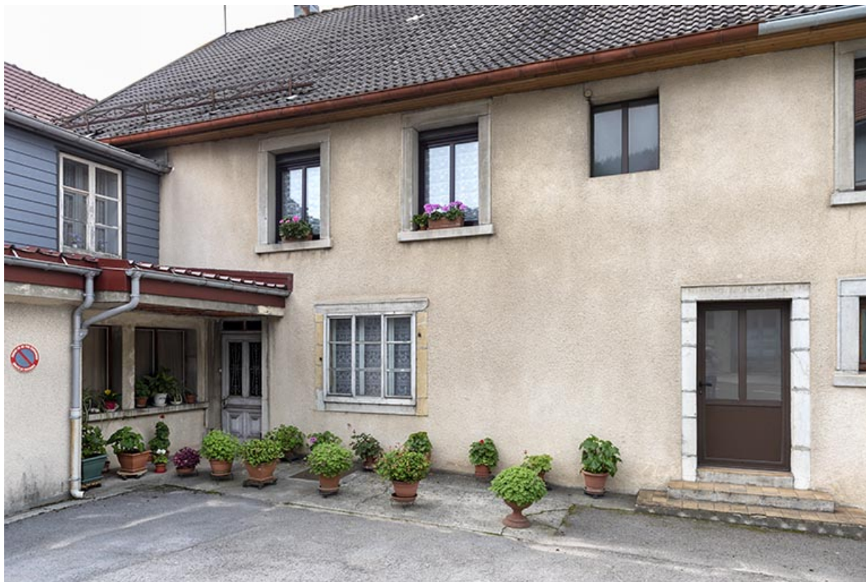
Ancien site : façade antérieure de la fonderie.
