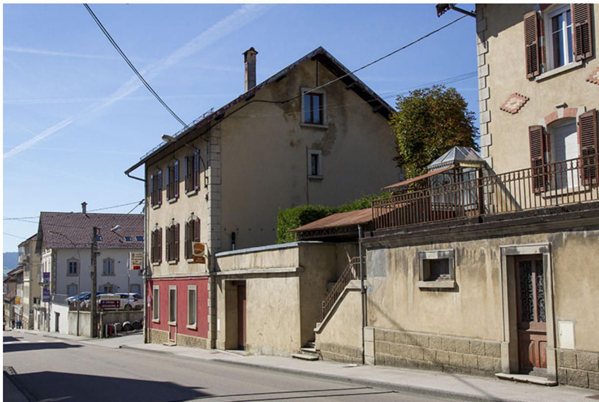
Maison et garage, vus du nord. 25, Morteau, 21 rue de la Louhière
