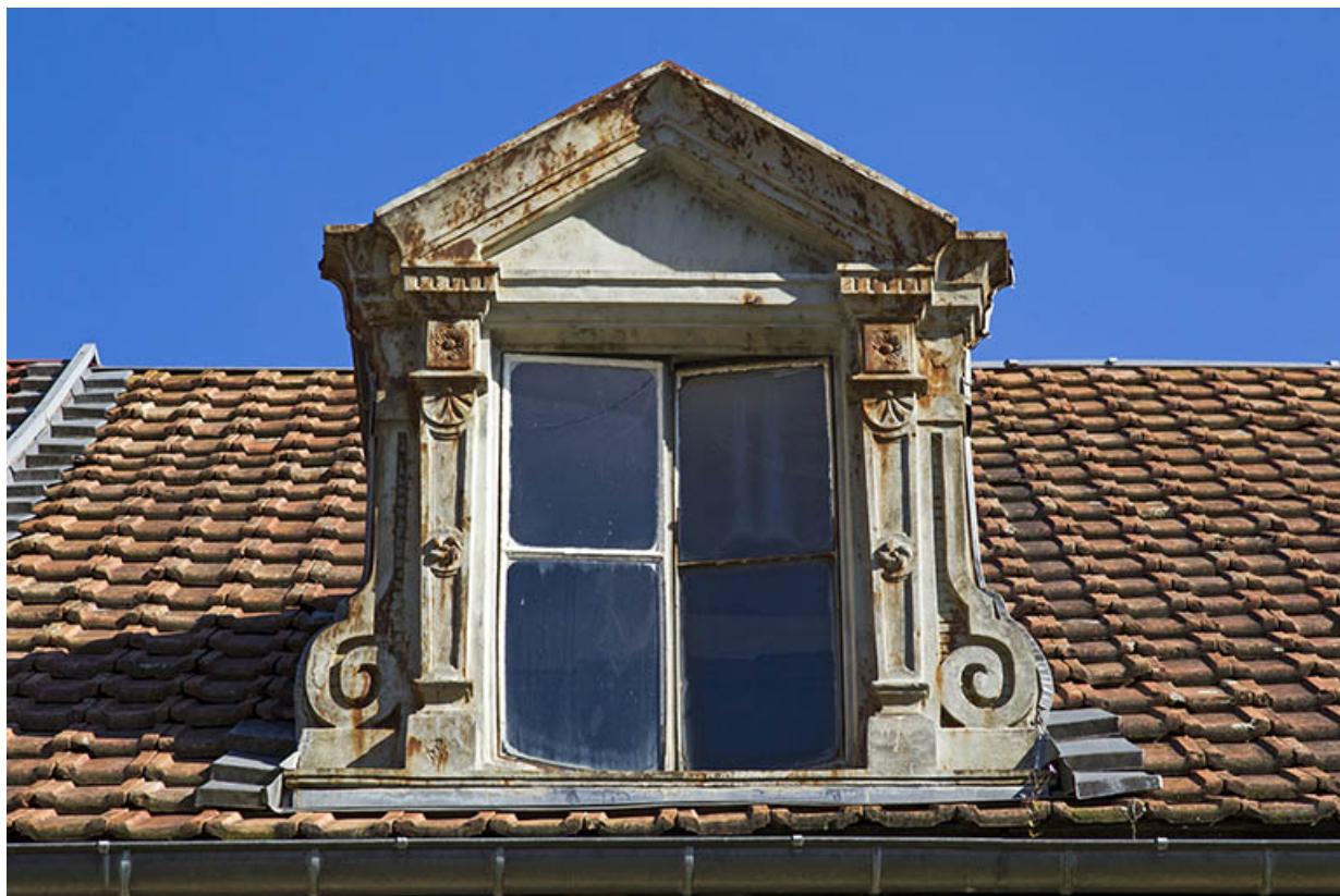
Corps sud, façade antérieure : lucarne.
