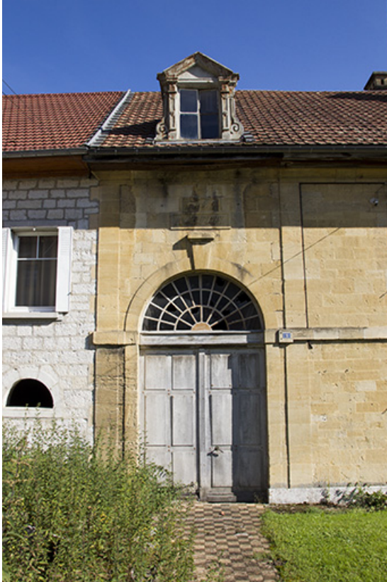
Corps sud, façade antérieure : entrée de la grange. 25, Morteau, 8-10 rue de la Louhière
