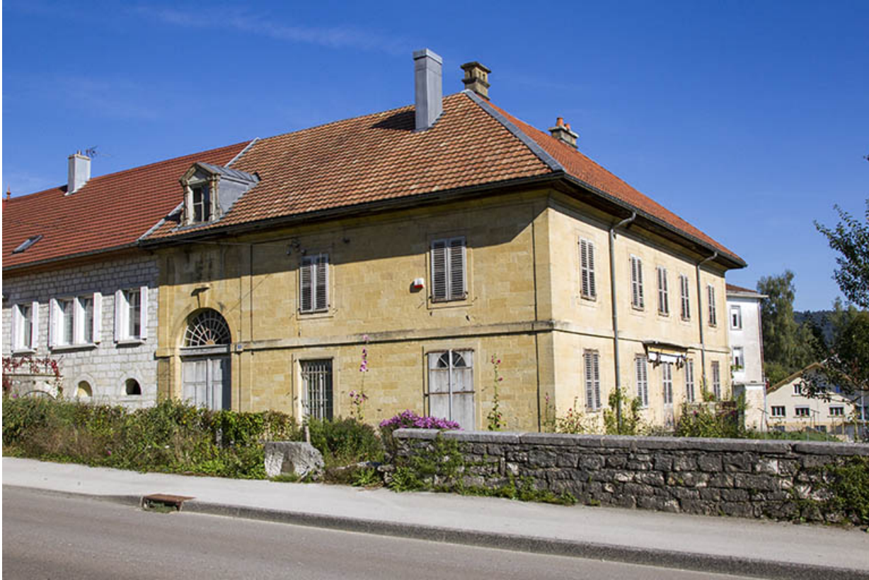
Corps sud : vue d'ensemble, depuis le sud-ouest.
