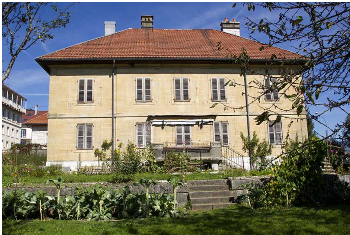
Corps sud : façade latérale droite.
