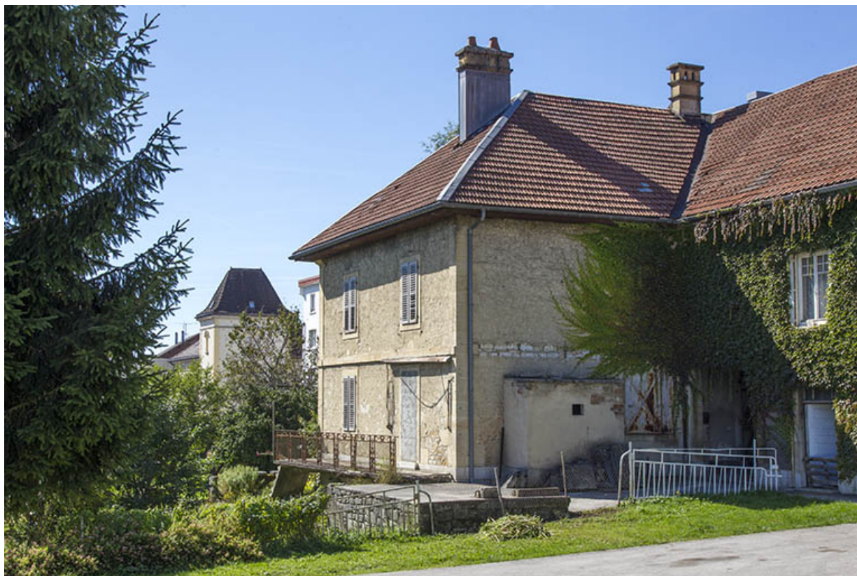
Corps sud : façades postérieure et latérale gauche.
