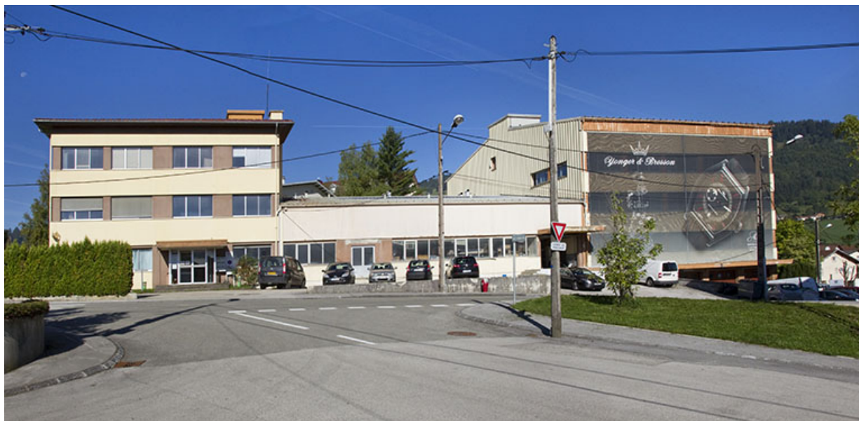
Usine d'horlogerie de la Société mortuacienne d'Horlogerie (Kiplé) puis de la SA Montres Ambre, 1 et 1A rue Fontaine-l'Epine. 25, Morteau
