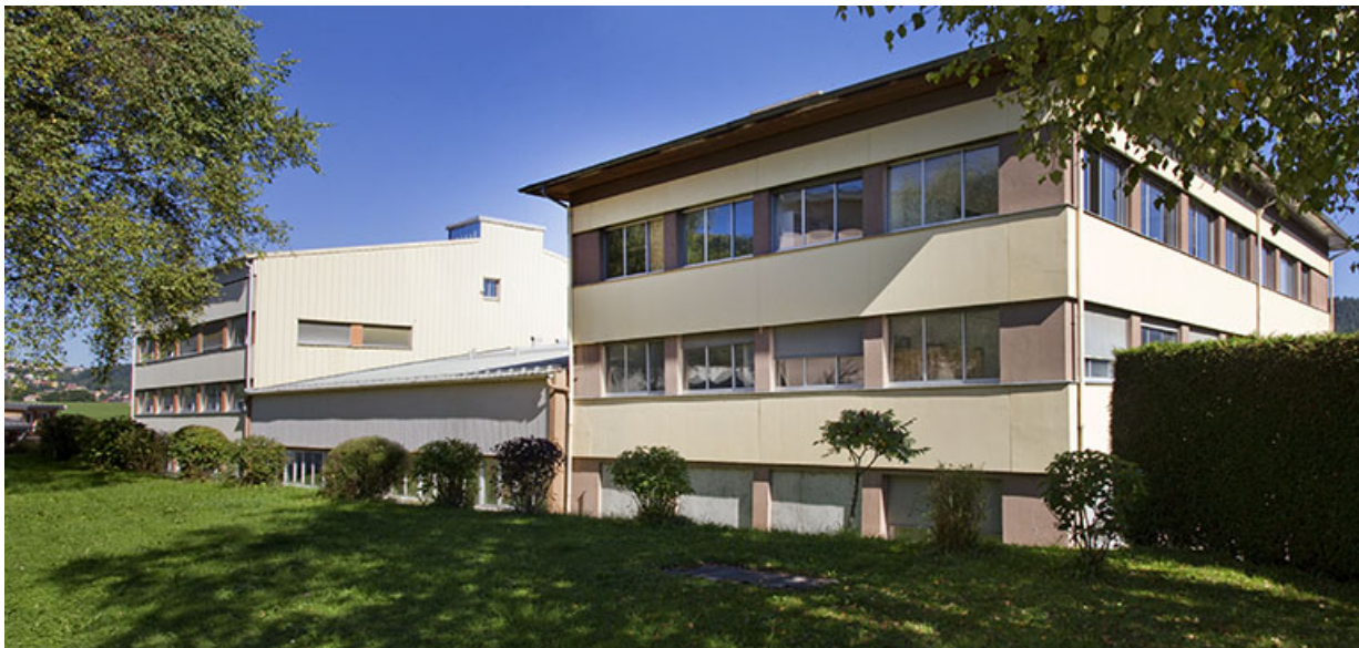
Vue d'ensemble, depuis le sud-ouest (façade postérieure).
