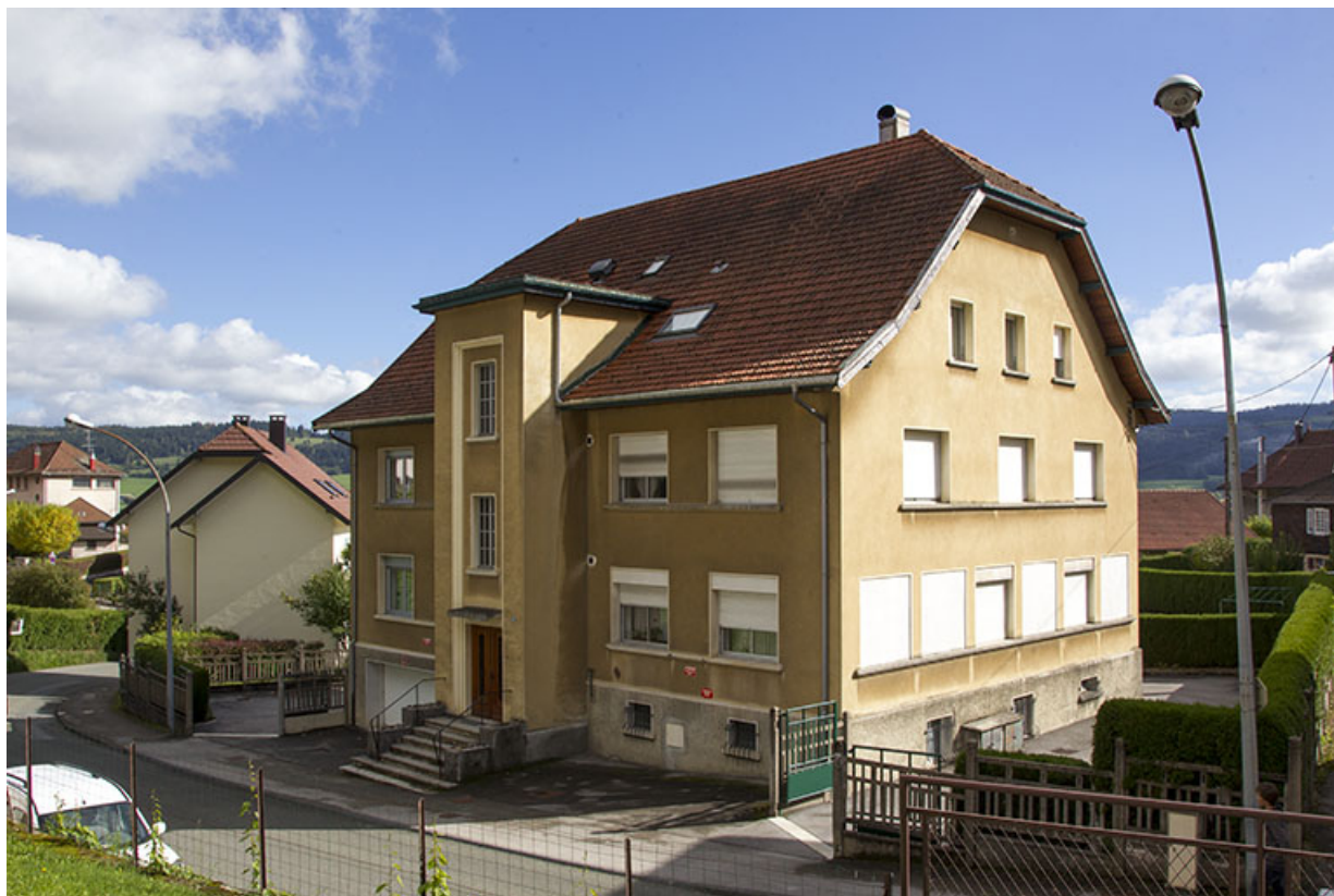
Vue d'ensemble, depuis l'ouest (façades antérieure et latérale droite). 25, Morteau
