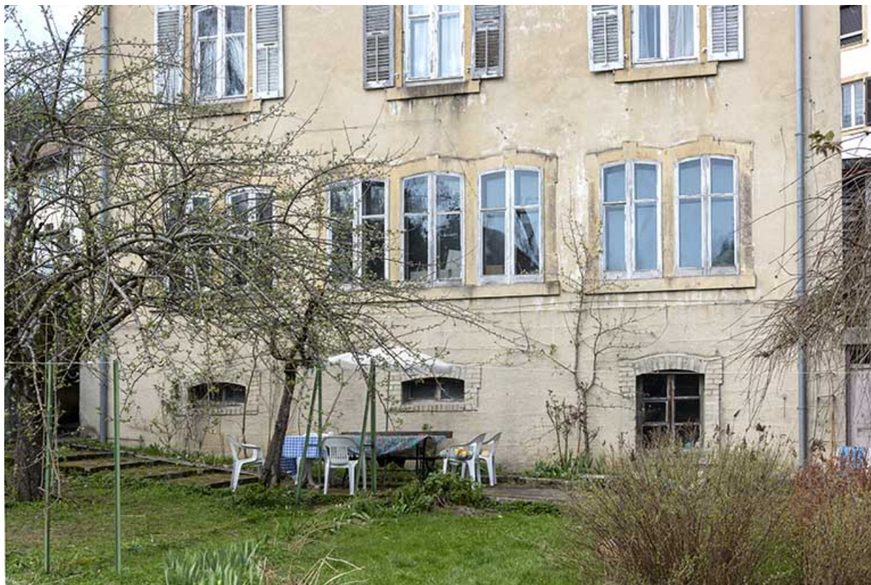
Façade postérieure : fenêtres horlogères et fenêtres multiples.
