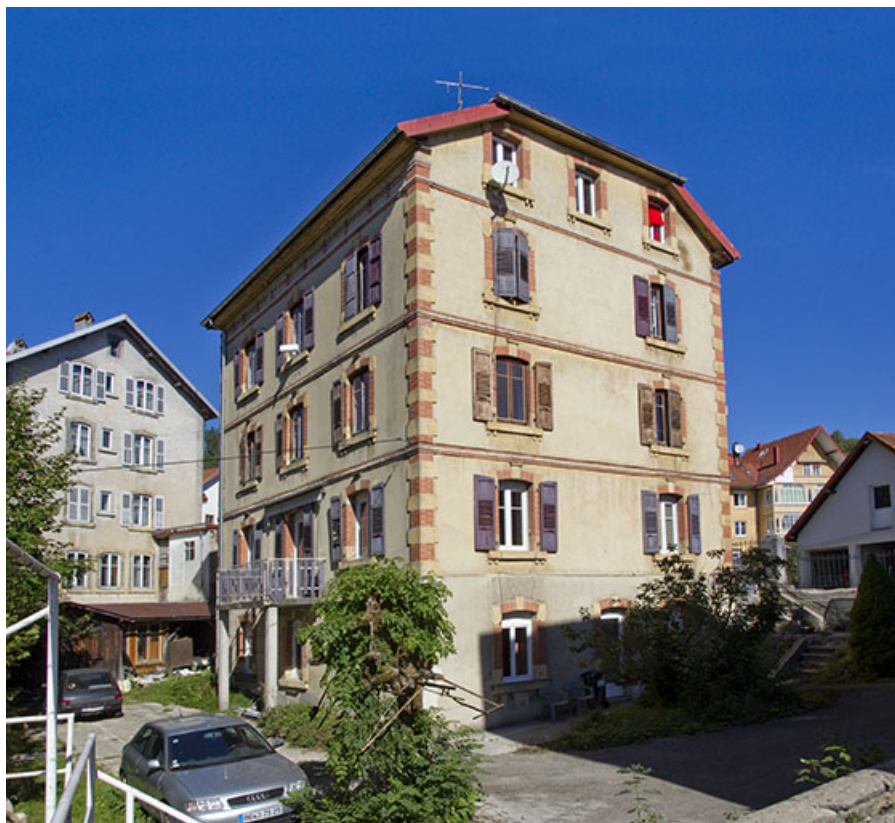
Façades postérieure et latérale gauche.
