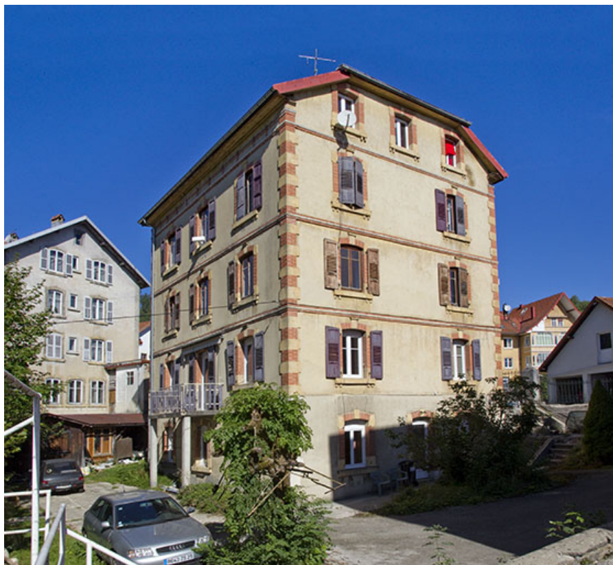
Façades postérieure et latérale gauche.
