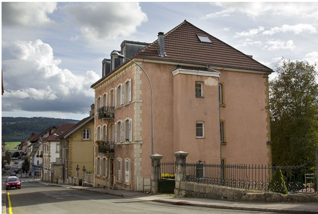
Vue d'ensemble, depuis le nord-ouest (façades antérieure et latérale droite). 25, Morteau, 7 rue Neuve
