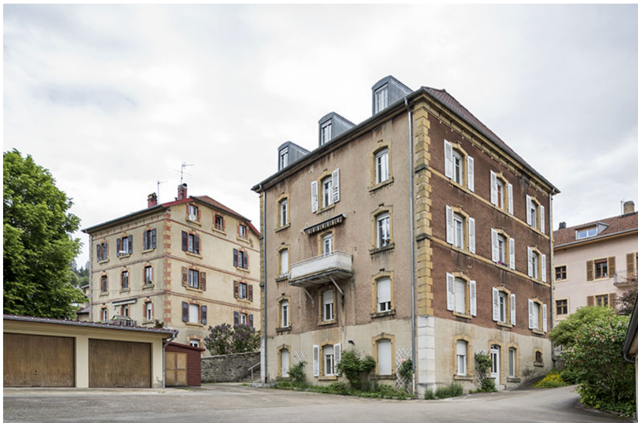
Façades postérieure et latérale gauche.
