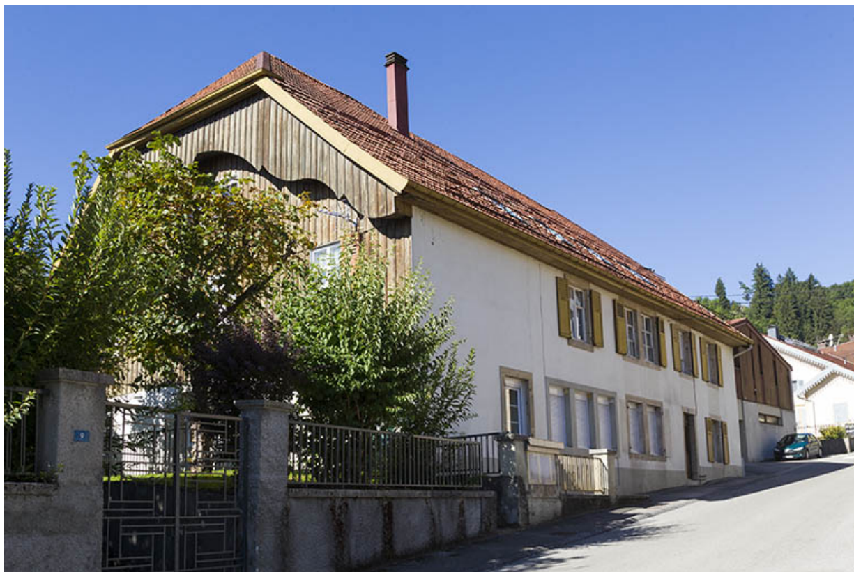
Ferme vue de l'est : façades antérieure et latérale gauche.
