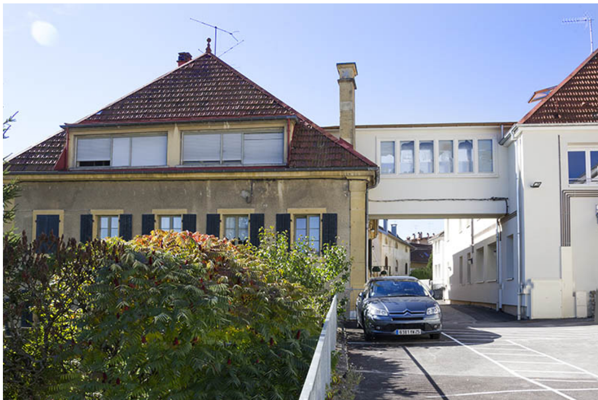
Maison : façade postérieure et passerelle. 25, Morteau, 22-24 rue Fauche
