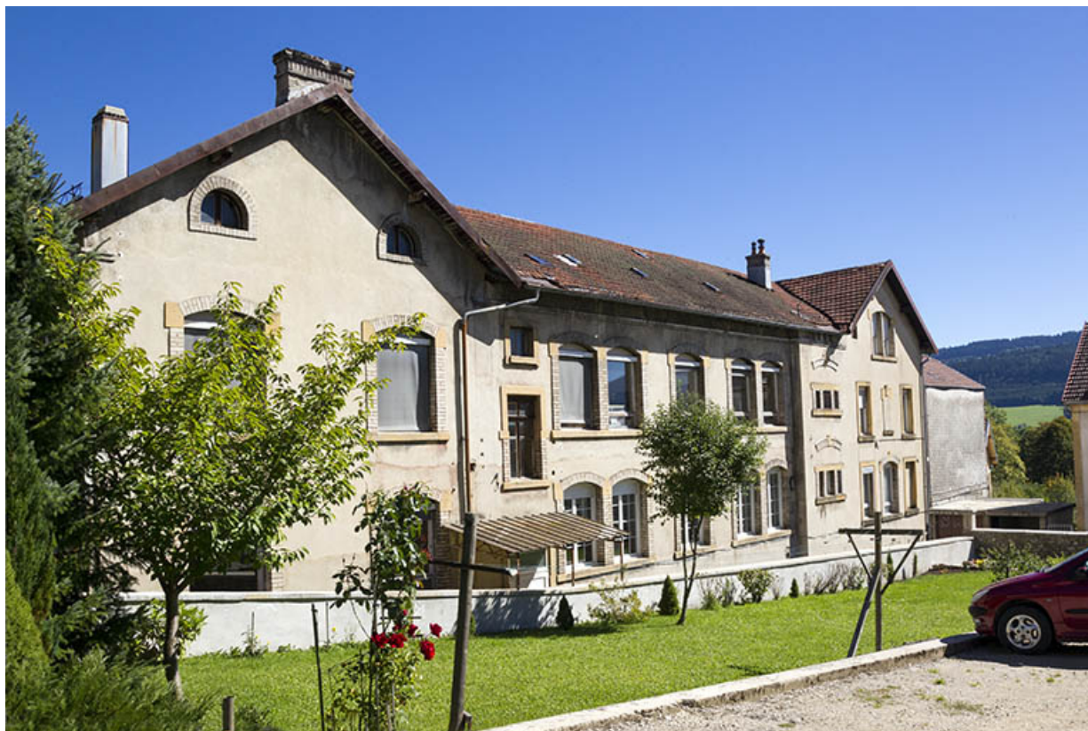
Aile ouest : façade occidentale, vue de trois quarts gauche.
