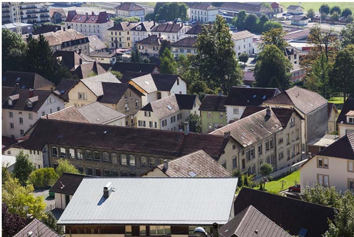
Vue d'ensemble plongeante, depuis le nord-ouest.
