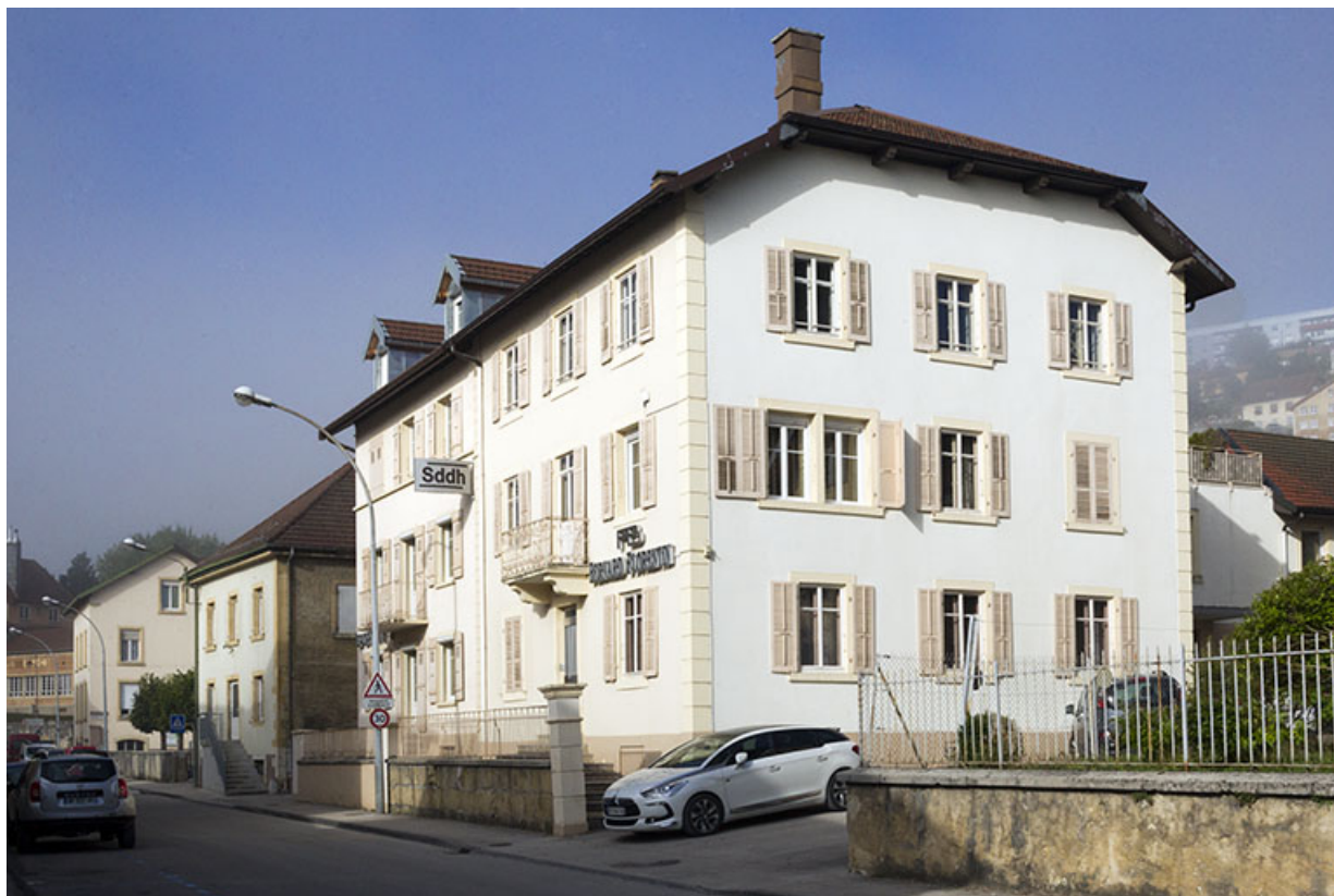
Façades antérieure et latérale droite. 25, Morteau, 26-28 rue de la Chaussée
