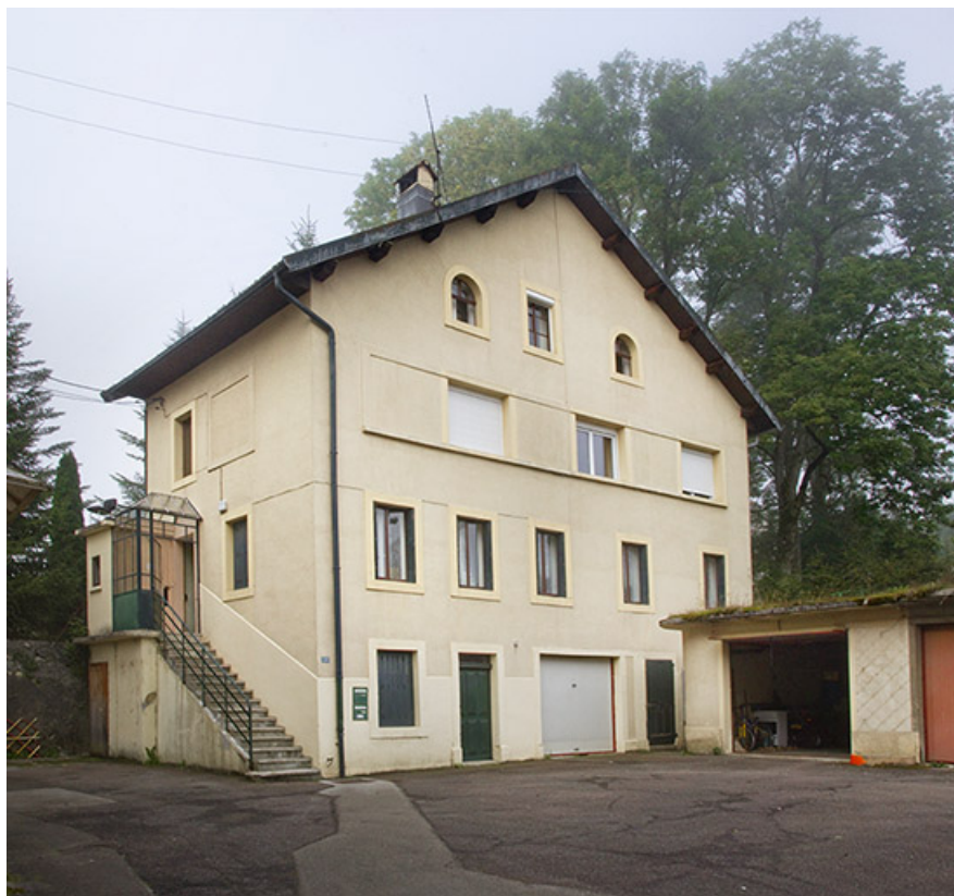
Bâtiment sur cour : façades antérieure et latérale gauche.
