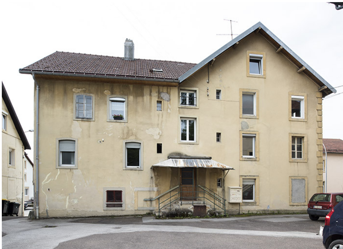
Bâtiment sur rue : façade postérieure.
