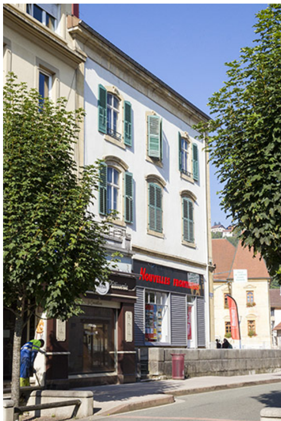
Façade latérale gauche, de trois quarts gauche. 25, Morteau, 1 place de l' Hôtel de Ville
