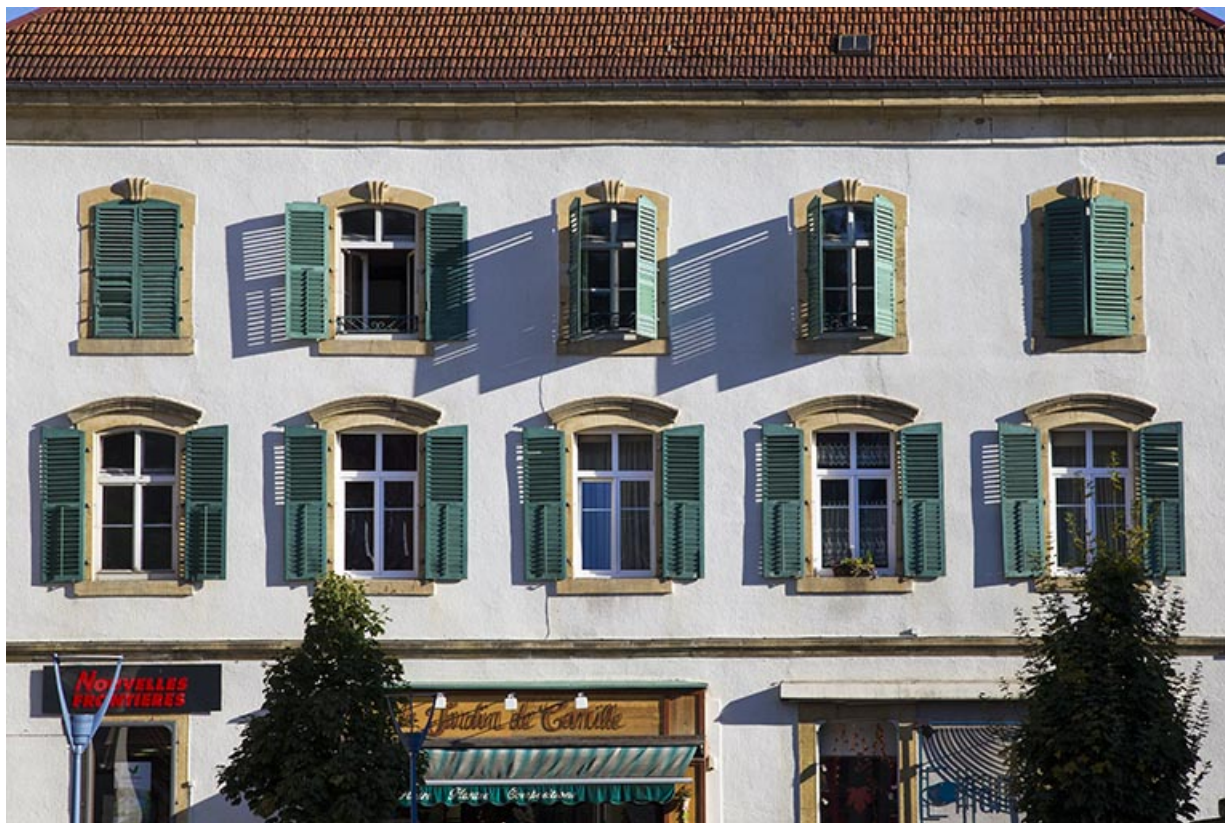
Façade antérieure : fenêtres des deux étages carrés.
