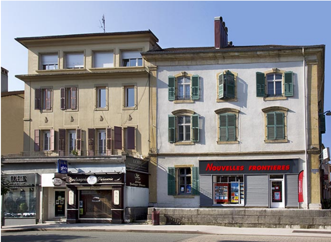
Vue d'ensemble de la façade latérale gauche (21 Grande Rue), avec le bâtiment au 19 Grande Rue. 25, Morteau
