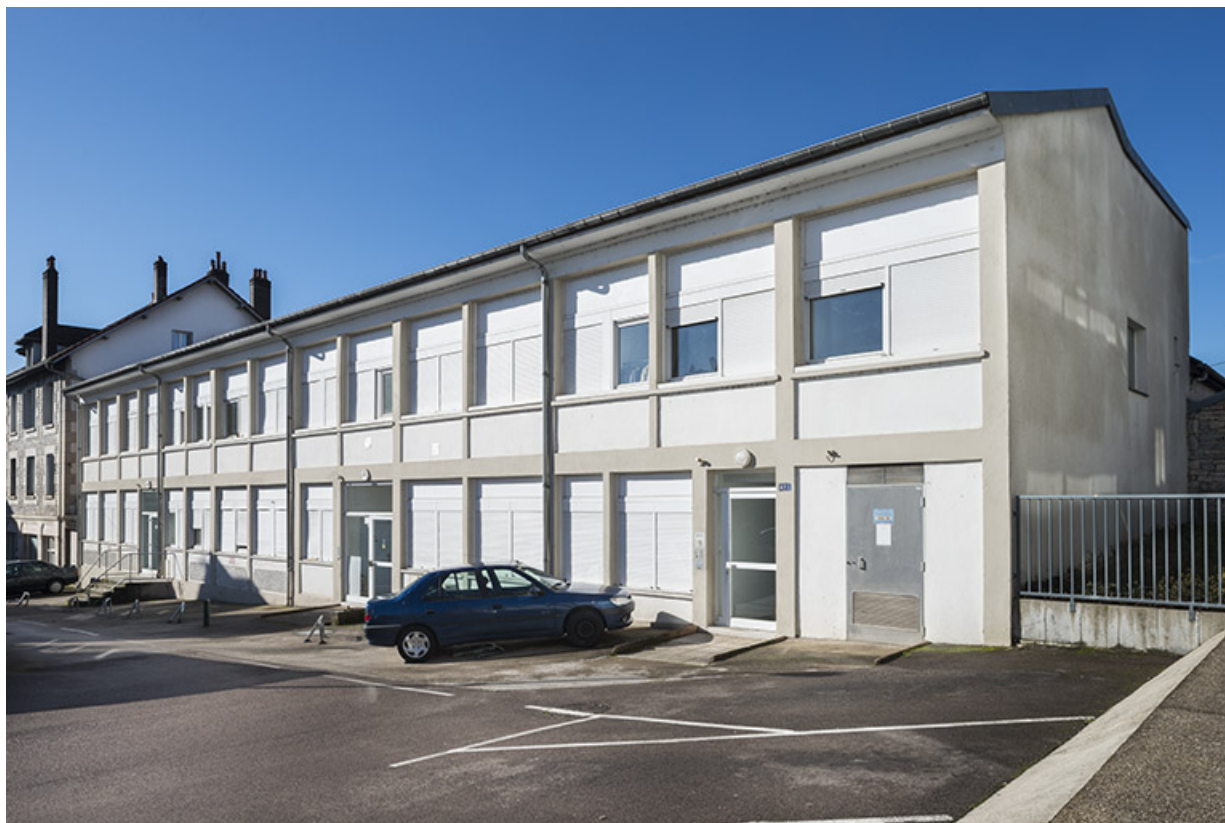
Façade est de l'atelier de fabrication. Vue de trois quarts droite.
