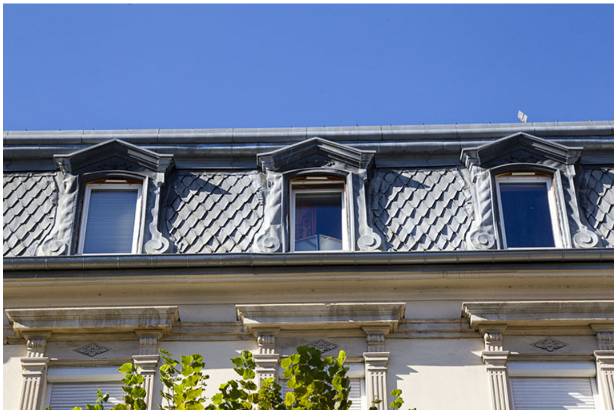
Façade antérieure : baies du brisis.
