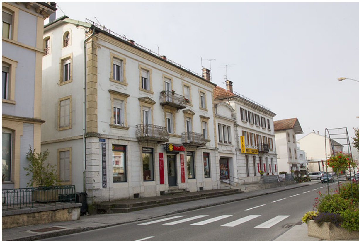
Vue d'ensemble, depuis le nord-est. 25, Morteau, 11-13 rue René Payot
