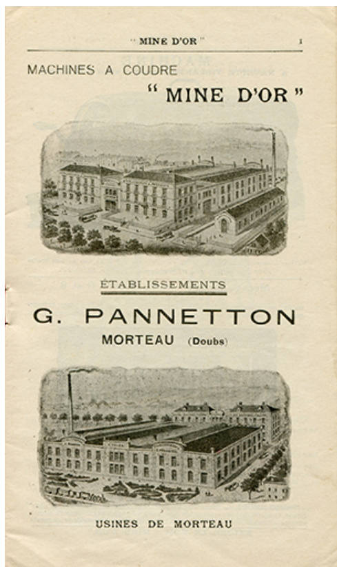
[Vues d'ensemble depuis le nord-ouest et depuis le sud-est], 1927. 25, Morteau, 11-13 rue René Payot
