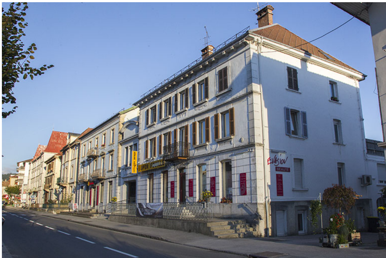
Vue d'ensemble, depuis l'ouest. 25, Morteau, 11-13 rue René Payot
