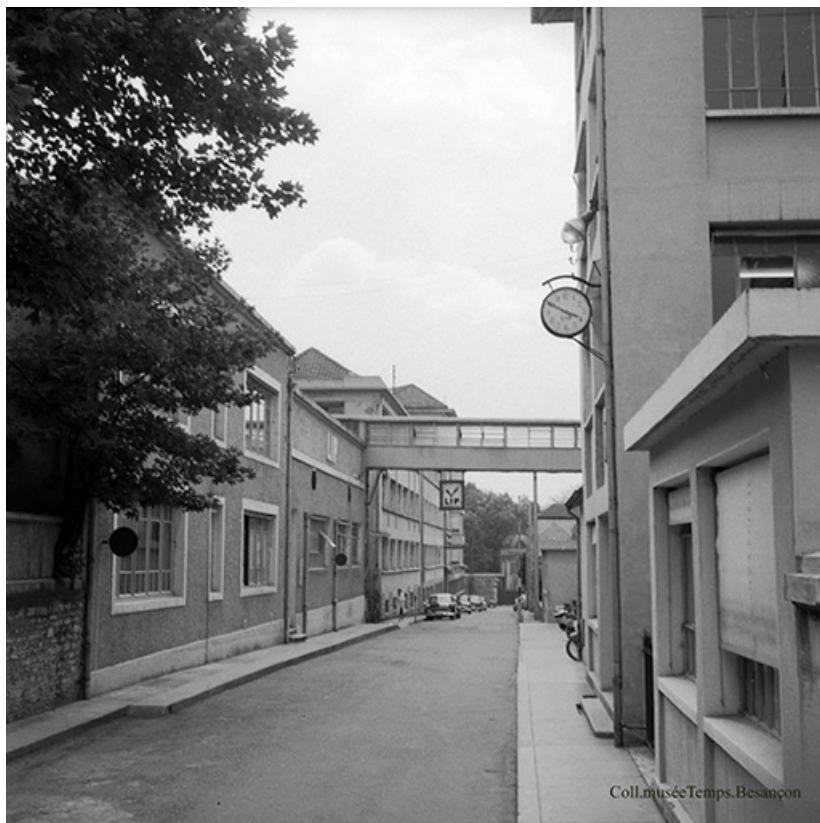
Rue des Chalets, s.d. [vers 1960]. 25, Besançon, 4 à 7 rue des Chalets
