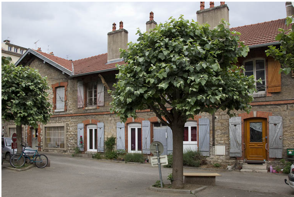
Atelier en pierre au n° 14B : façade antérieure, de trois quarts droite. 25, Besançon, 14 avenue Fontaine-Argent
