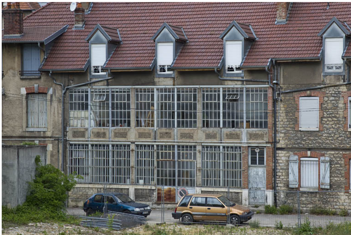
Atelier en béton au n° 14B : partie centrale de la façade postérieure. 25, Besançon, 14 avenue Fontaine-Argent
