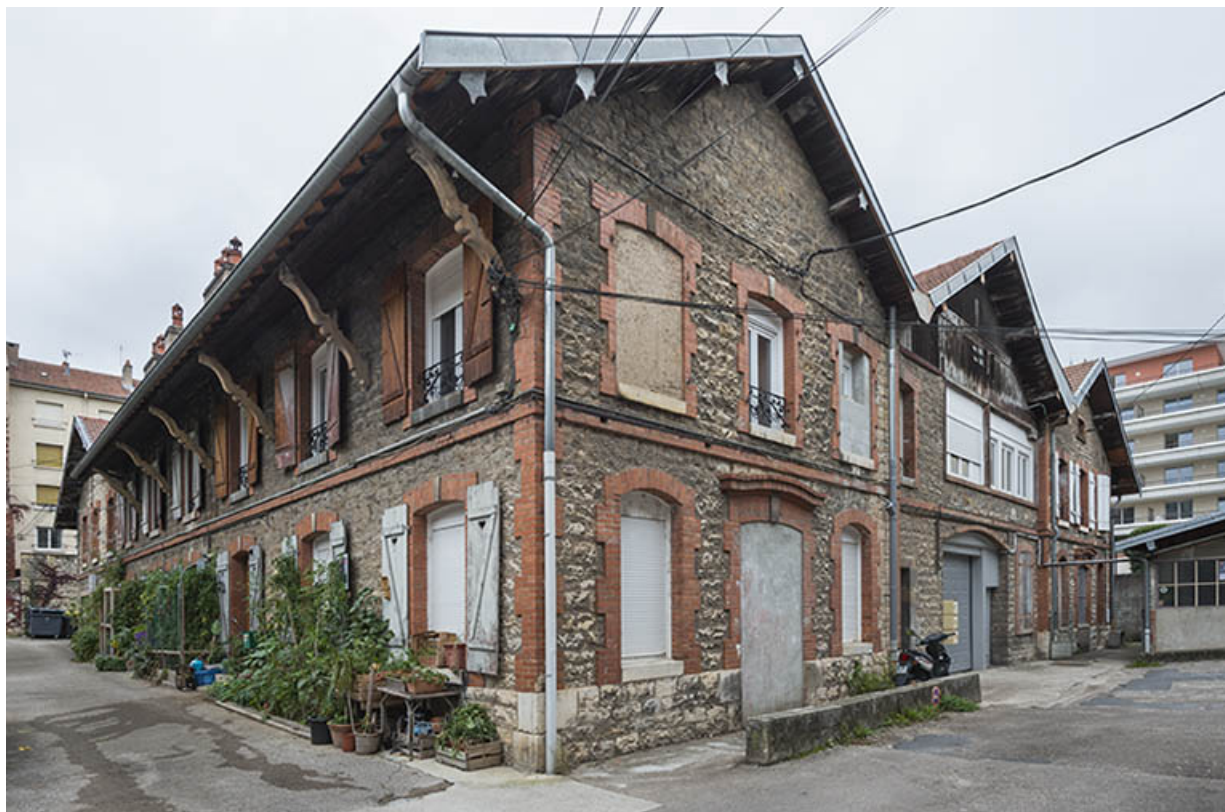
Bâtiment de la distillerie, depuis le sud. 25, Besançon, 14 avenue Fontaine-Argent
