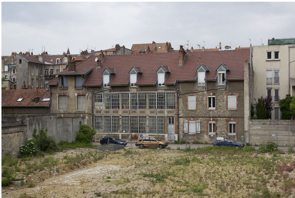
Atelier en béton au n° 14B : façade postérieure. 25, Besançon, 14 avenue Fontaine-Argent
