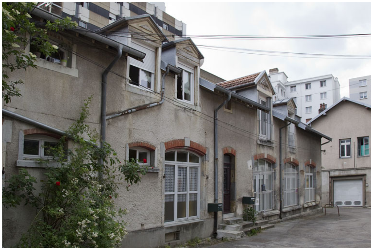
Atelier dans le prolongement au sud de celui en béton (13B rue de la Mouillère) : façade antérieure, de trois quarts gauche. 25, Besançon, 14 avenue Fontaine-Argent
