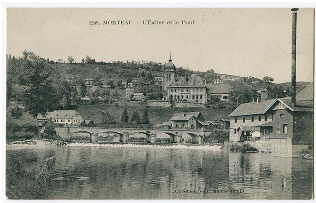
1249. Morteau - L'église et le pont, 1er quart 20e siècle [entre 1917 et 1922].
