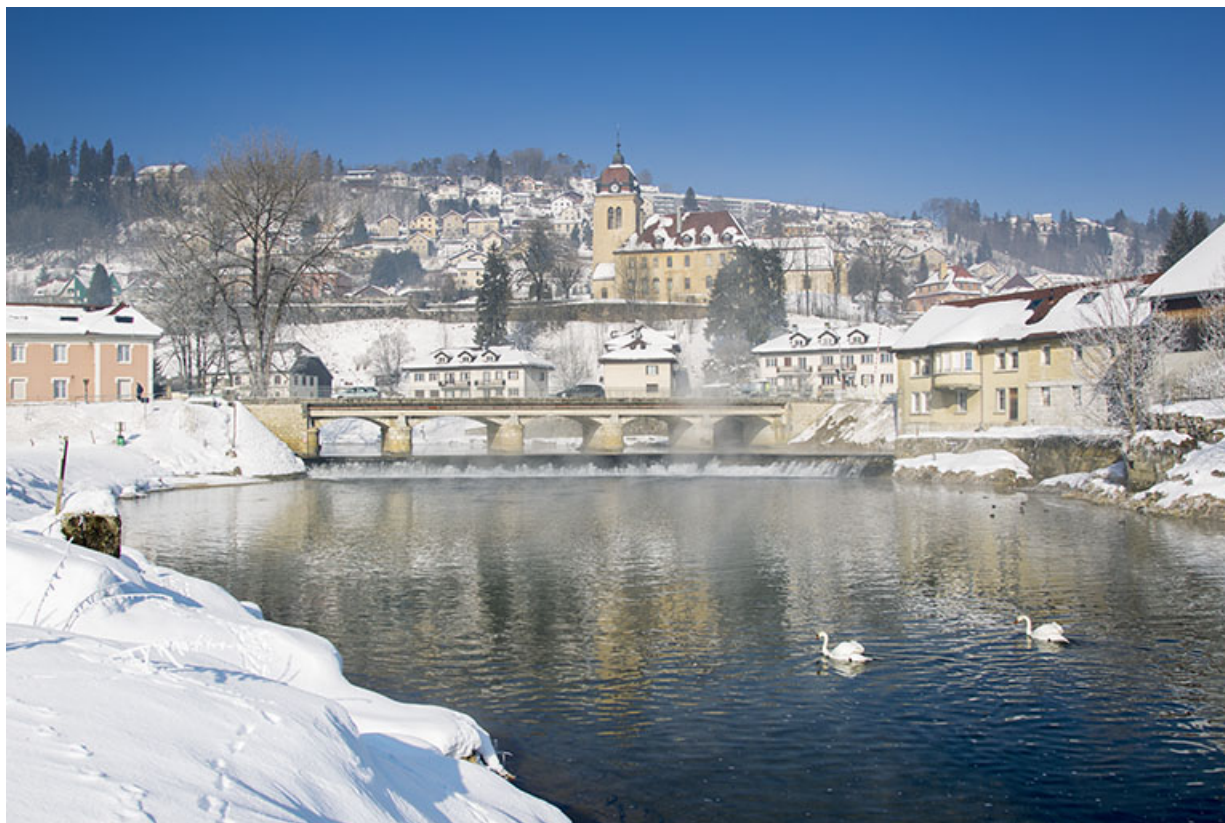
Vue d'ensemble du site en hiver, depuis le sud-est.
