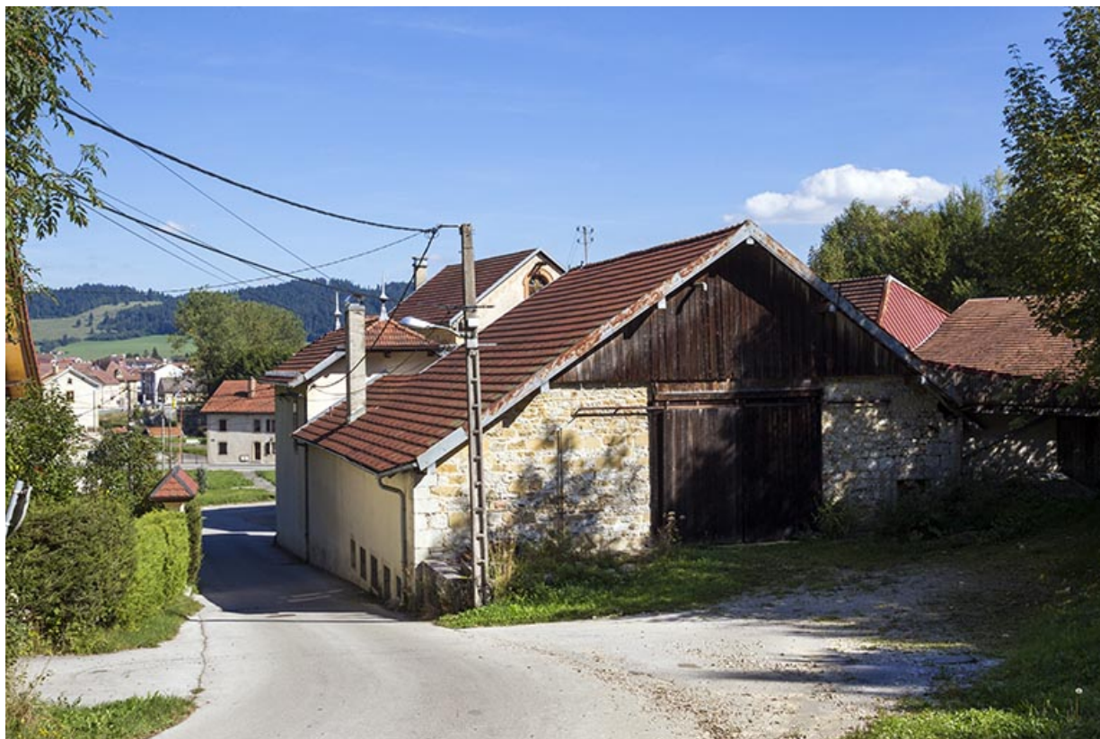
Bureau, écurie et grange, depuis l'ouest.
