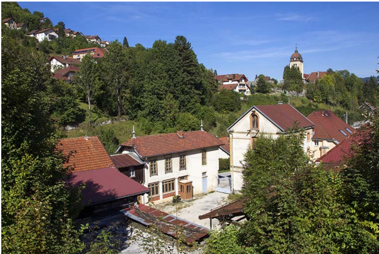
Vue d'ensemble plongeante, depuis le sud.
