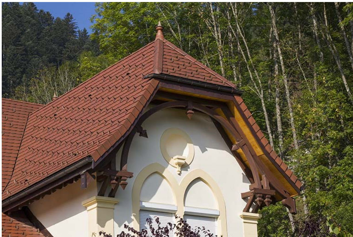
Logement patronal, façade occidentale : baies. 25, Morteau, 1-4 rue de la Brasserie
