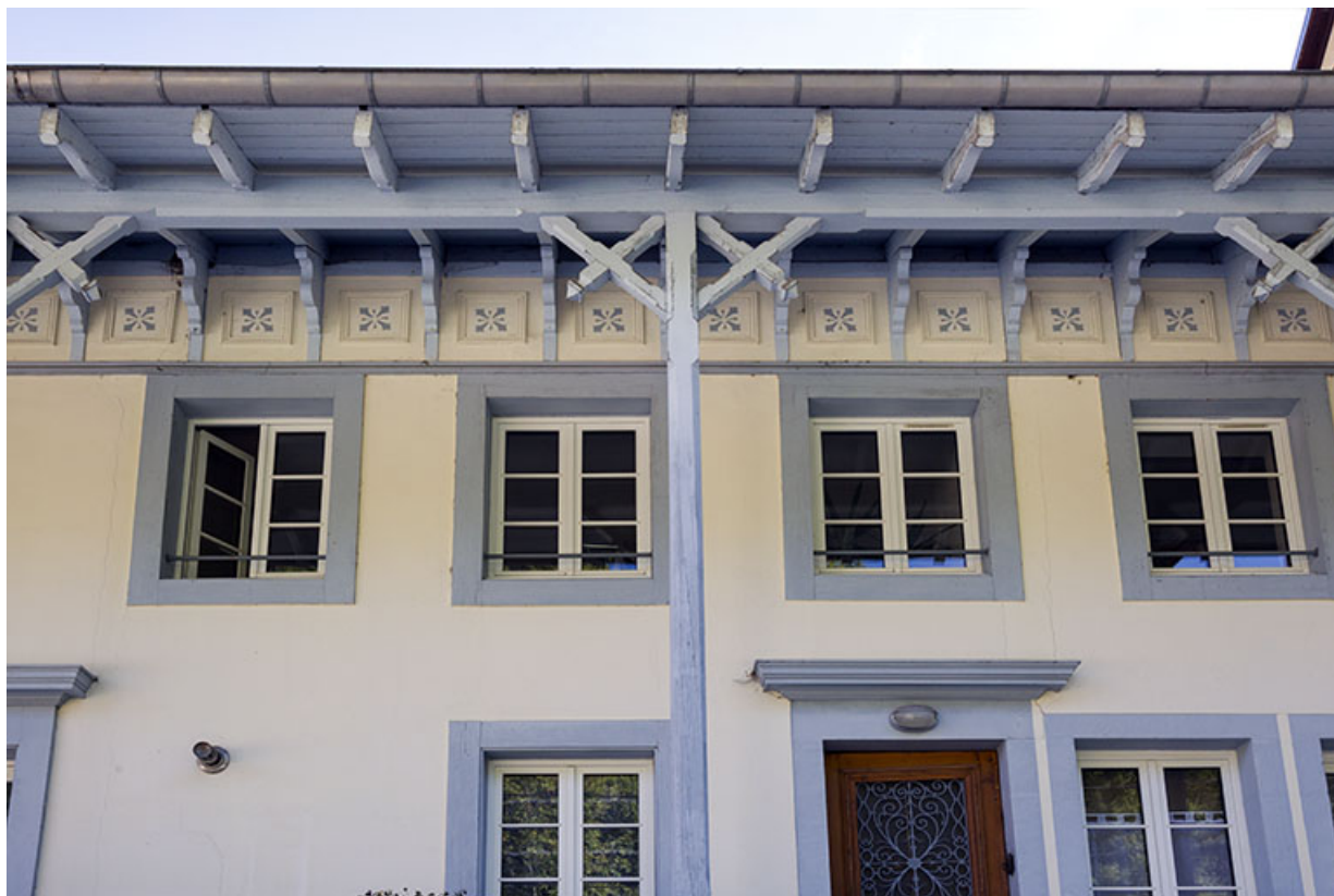
Premier atelier de fabrication, façade antérieure : baies et décor.
