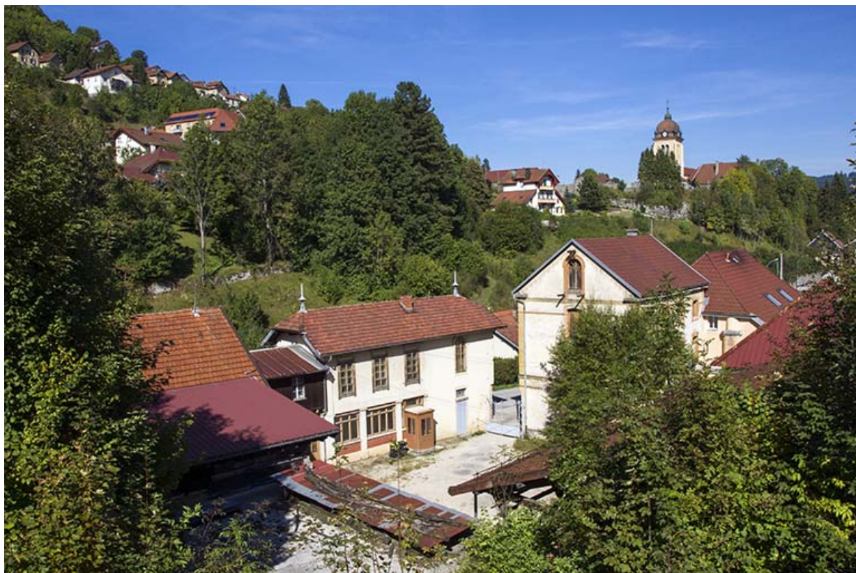
Vue d'ensemble plongeante, depuis le sud.
