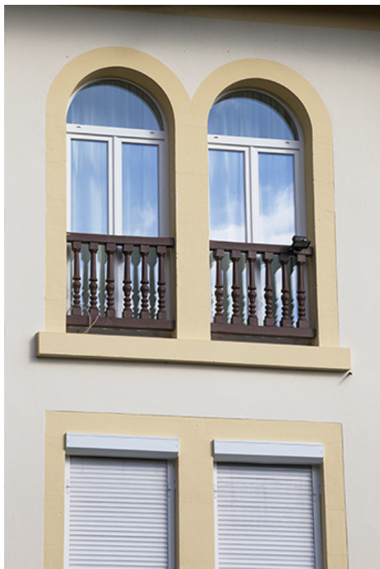
Logement patronal, façade méridionale : fenêtres.
