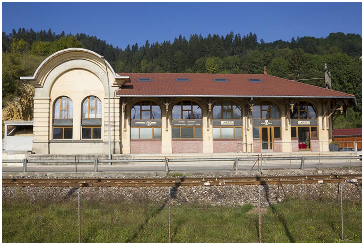
Ateliers de traitement des fûts (à gauche) et de conditionnement : façade orientale. 25, Morteau, 1-4 rue de la Brasserie
