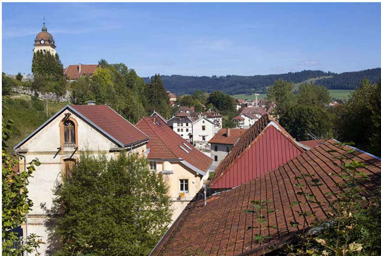
Ateliers de fabrication (à gauche), entrepôt et magasin industriels (à droite). 25, Morteau, 1-4 rue de la Brasserie
