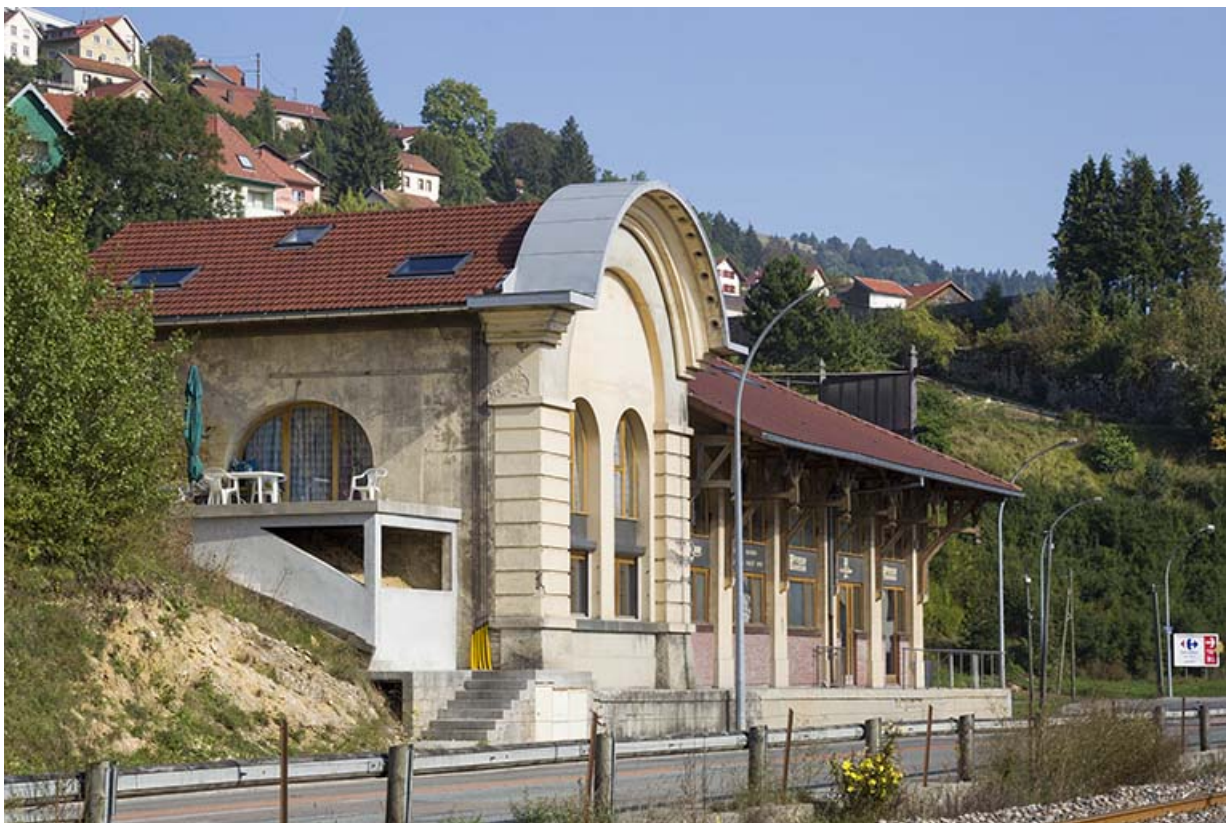
Ateliers de traitement des fûts (à gauche) et de conditionnement : façade orientale, vue en enfilade. 25, Morteau, 1-4 rue de la Brasserie
