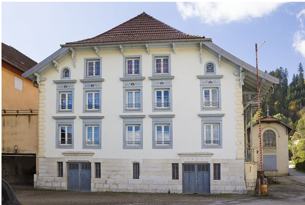
Premier atelier de fabrication : façade latérale gauche.
