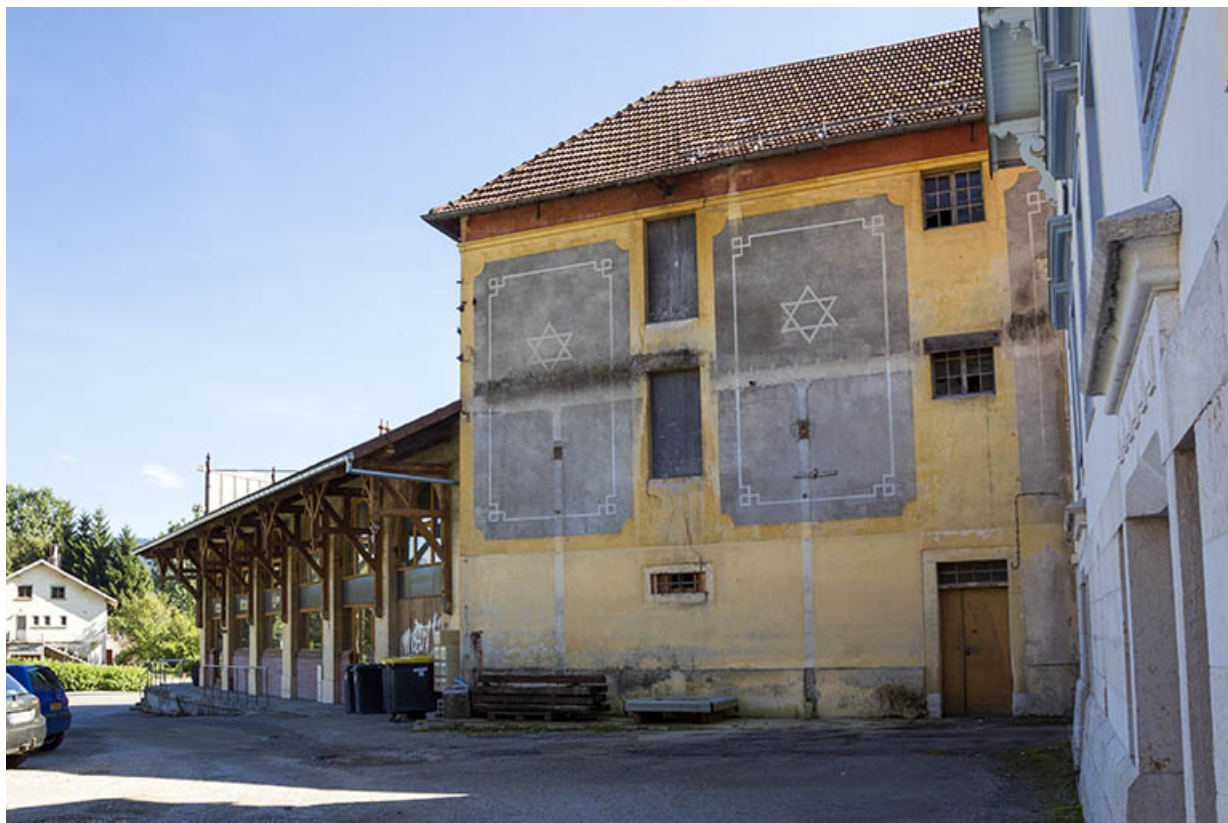
Entrepôt industriel : extrémité orientale, entre l'atelier de conditionnement (à gauche) et le premier atelier de fabrication (à droite). 25, Morteau, 1-4 rue de la Brasserie
