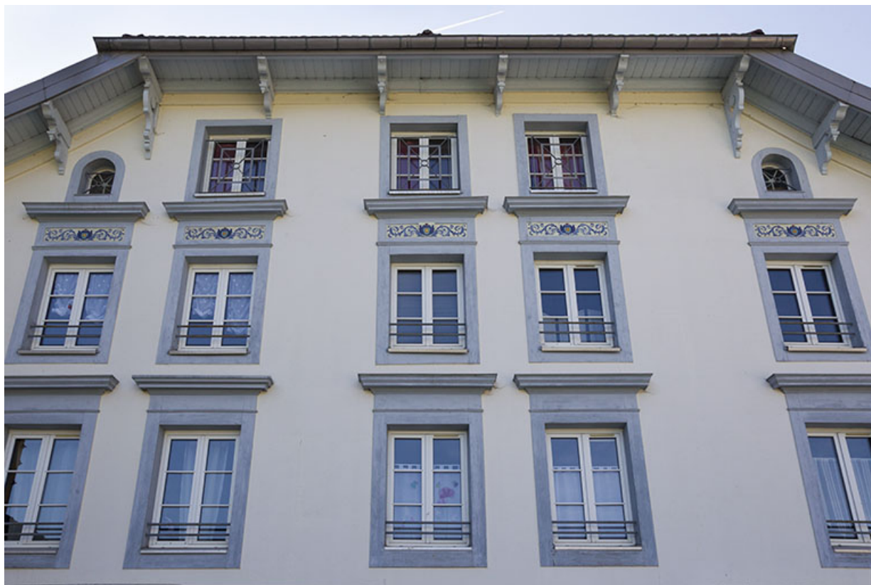
Premier atelier de fabrication, façade latérale gauche : fenêtres des étages, vues en contre-plongée. 25, Morteau, 1-4 rue de la Brasserie
