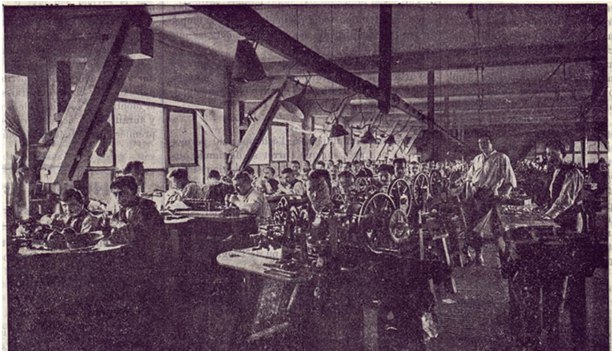
Vue générale de l'Atelier Bornet
