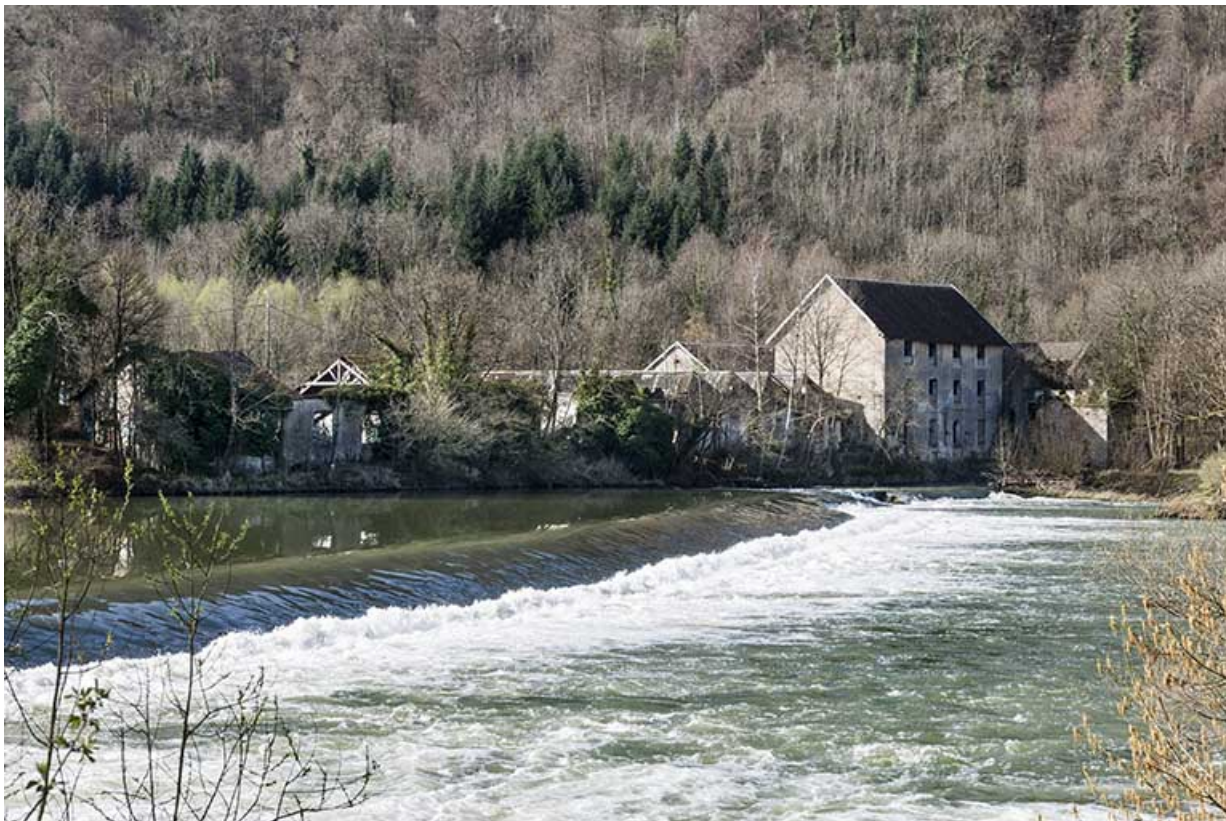
Vue rapprochée depuis la rive droite.
