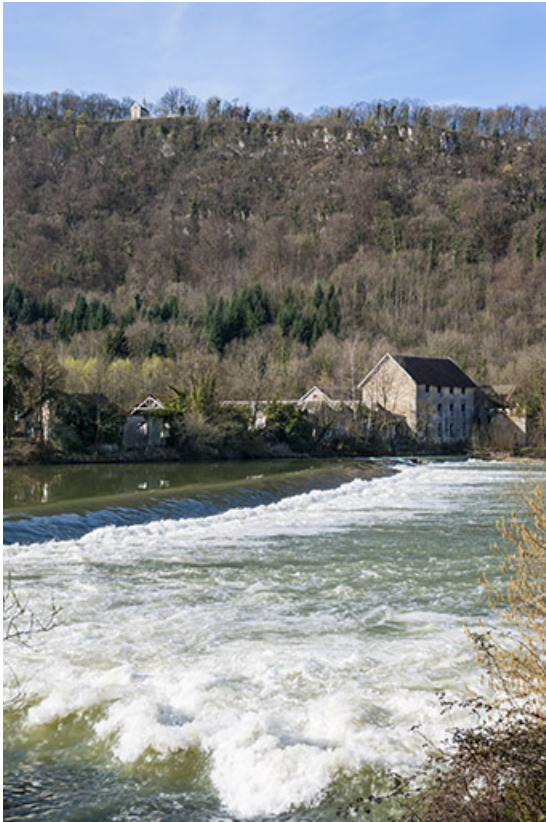
Vue d'ensemble depuis la rive droite.
