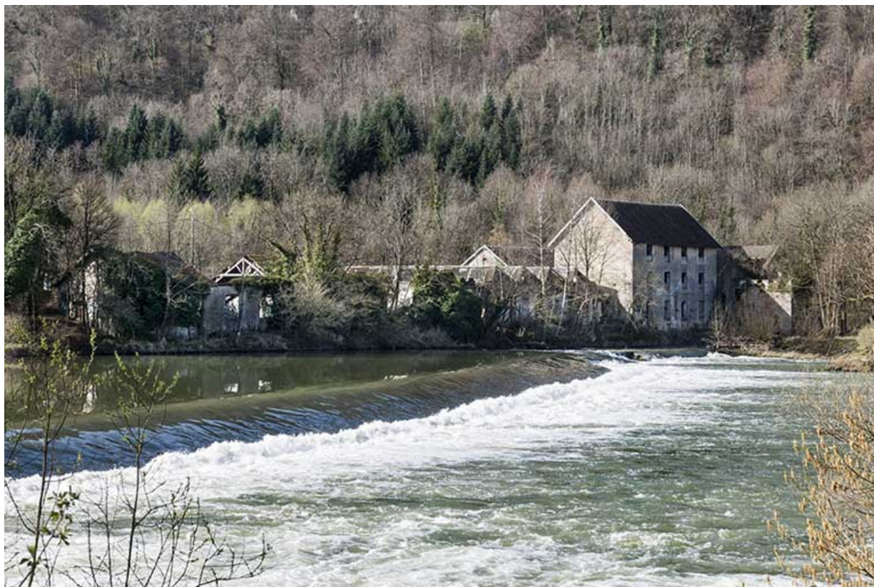
Vue rapprochée depuis la rive droite.
