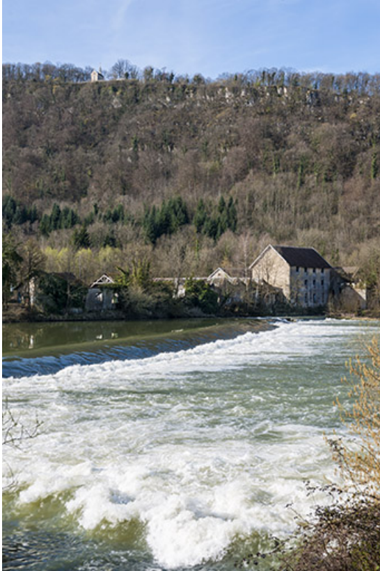
Vue d'ensemble depuis la rive droite.
