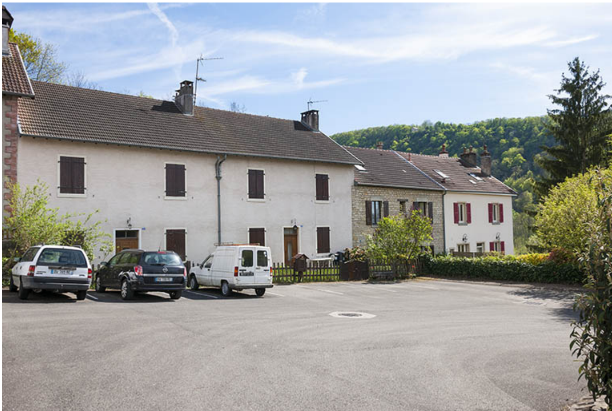
Façade ouest des logements contigus (26-28 rue des Usines). 25, Montferrand-le-Château rue des Usines
