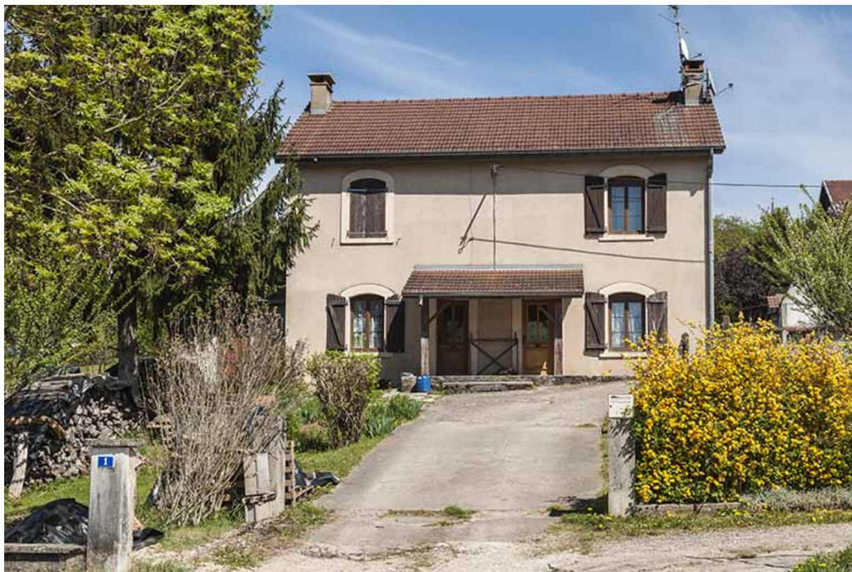
Maison ouvrière à deux logements (3 rue des Salines).
