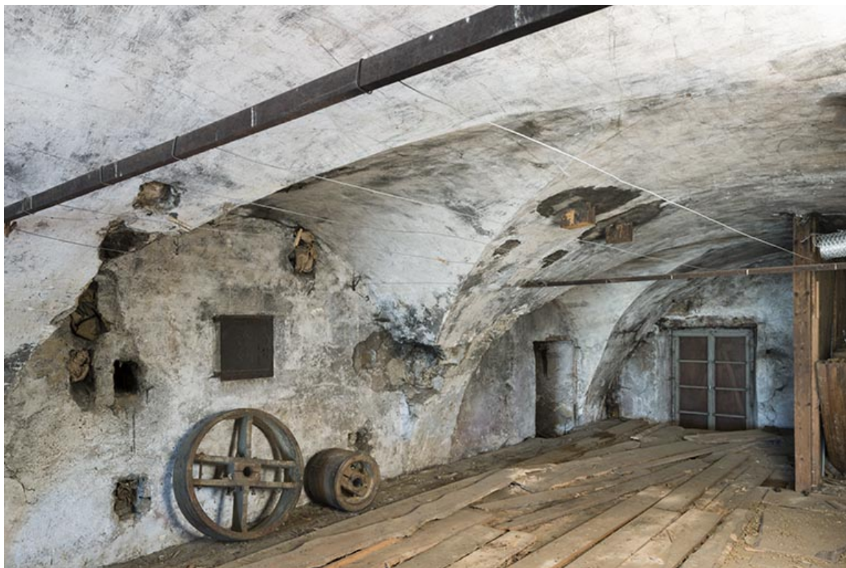
Bâtiment ancien, partie centrale : voûte d'arêtes au 2e étage.
