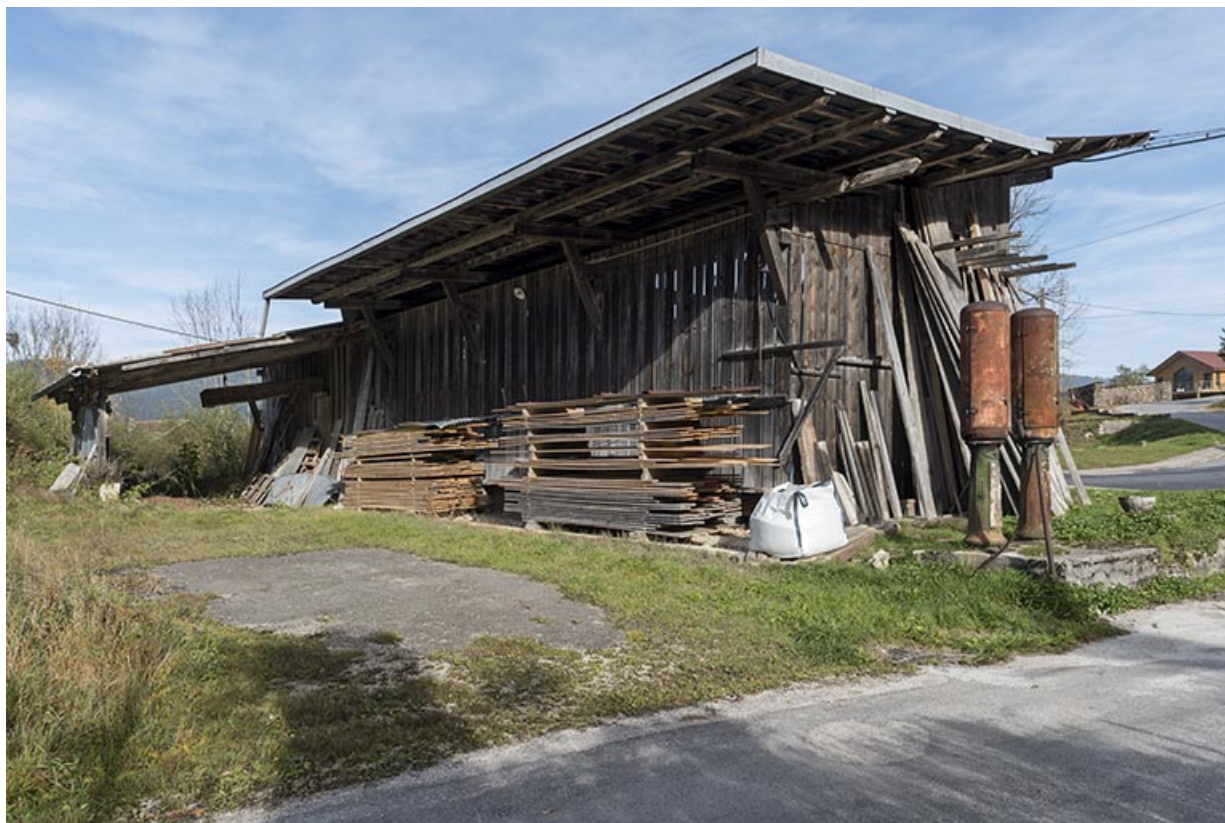
Séchoir à bois et pompes à carburant, à l'ouest. 25, Montlebon, 13 rue du Moulin, lieudit : Cornabey
