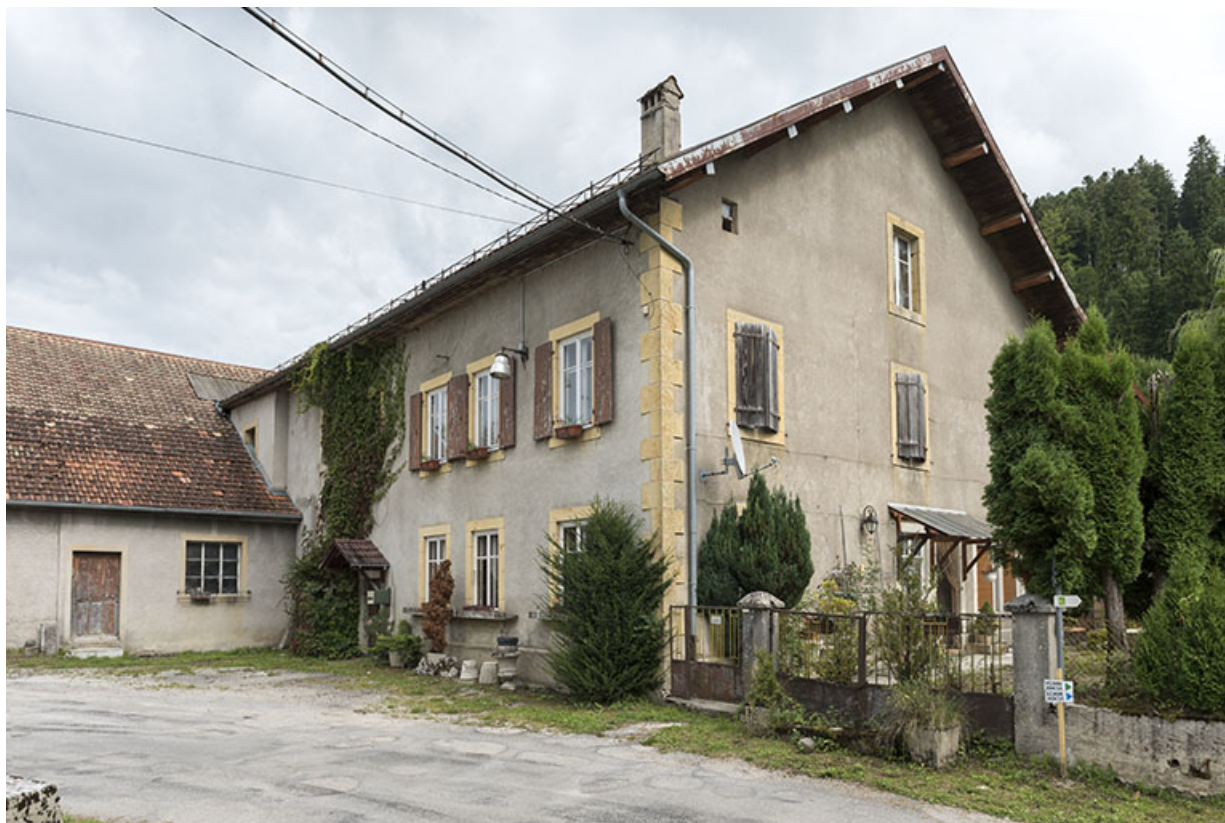
Bâtiment ancien : façades antérieure et latérale droite.
