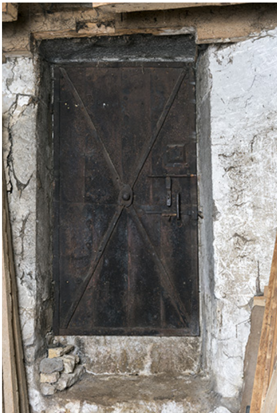
Bâtiment ancien, partie centrale : porte en fer au 1er étage.
