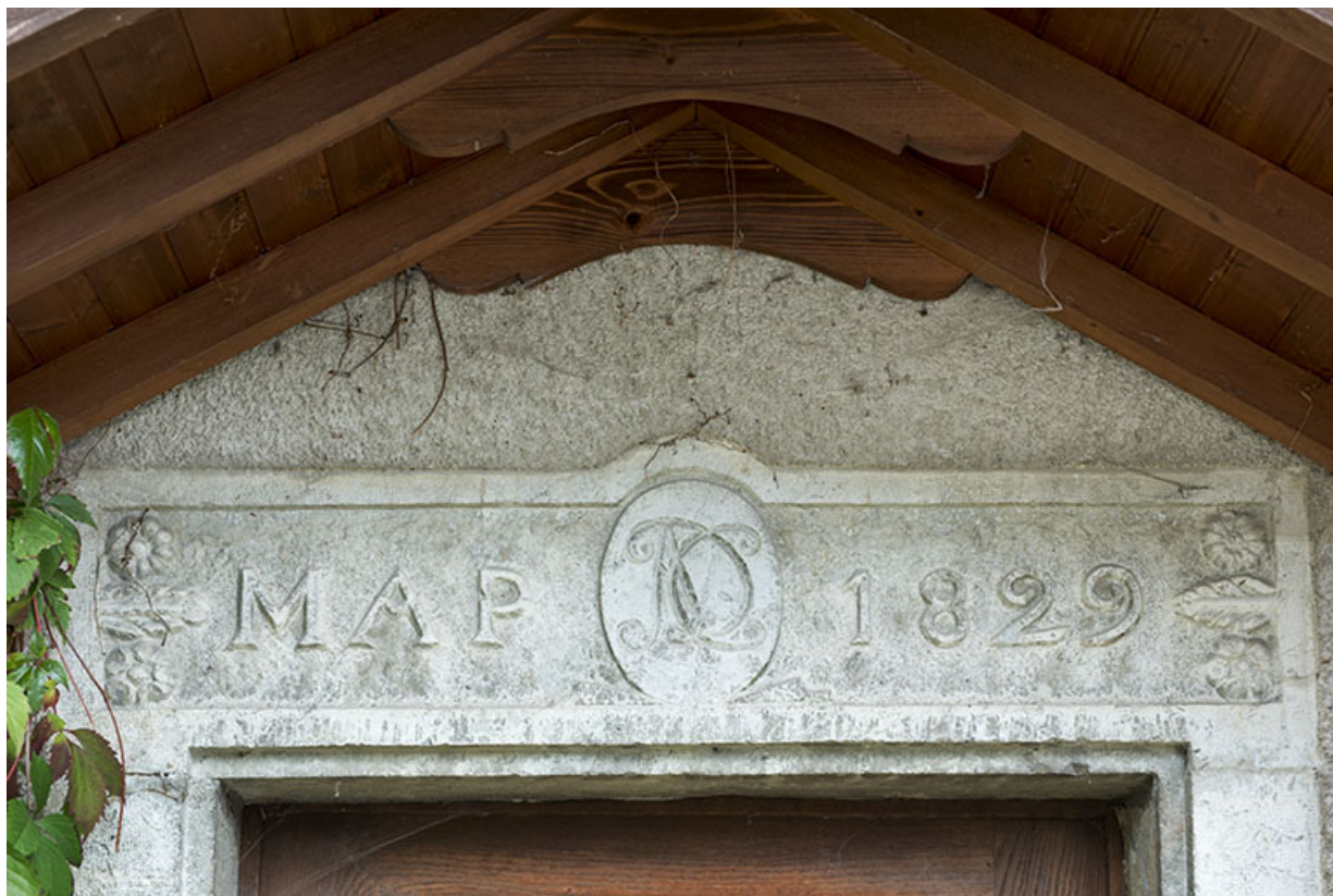
Bâtiment ancien : linteau daté 1829 sur la façade antérieure.
