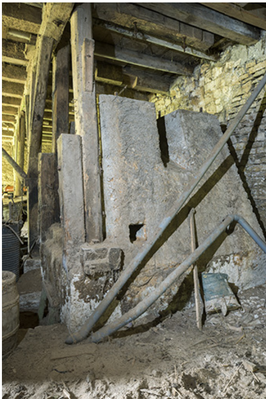
Scierie : socle en maçonnerie d'un châssis de scie.
