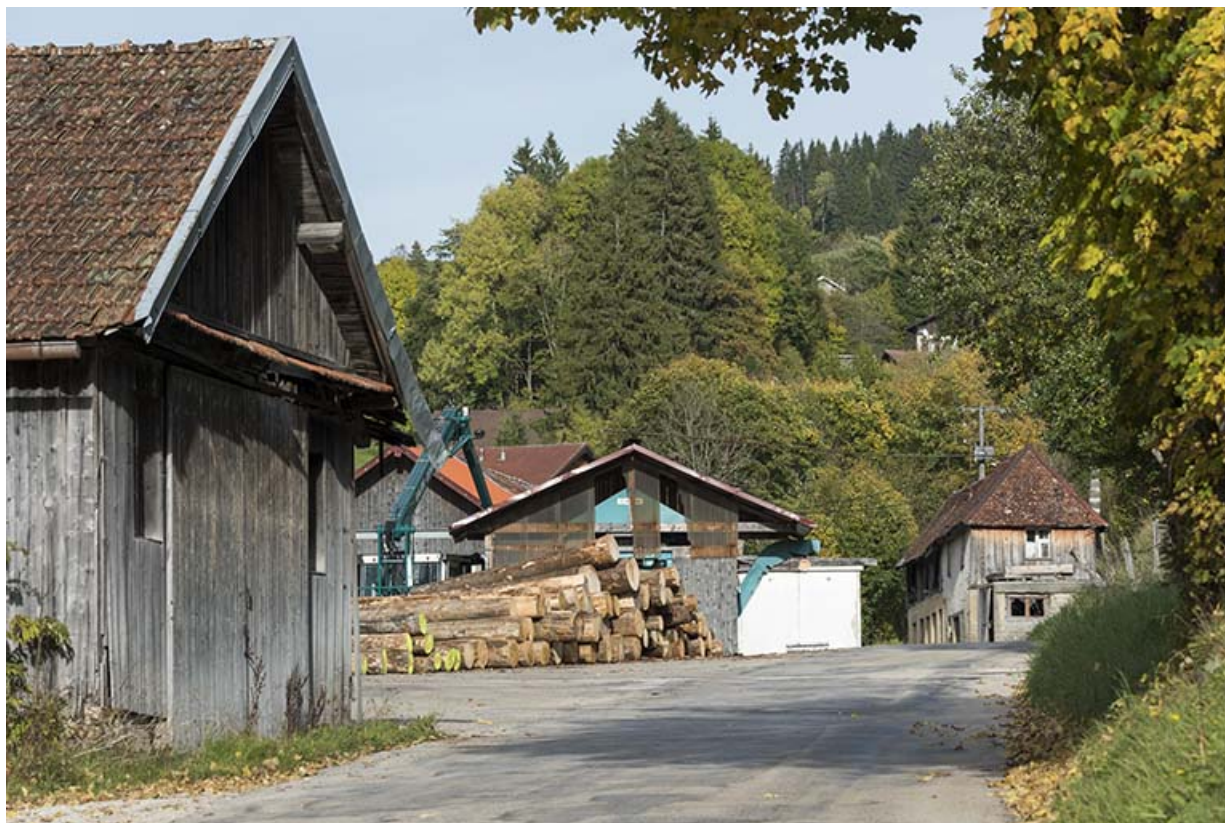
Vue d'ensemble depuis la route, au sud-ouest.
