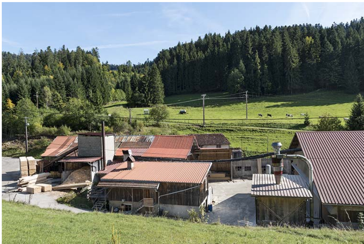
Vue plongeante sur les ateliers, depuis le nord-ouest. Au centre, la maison des années 1860. 25, Montlebon, lieudit : Derrière le Mont
