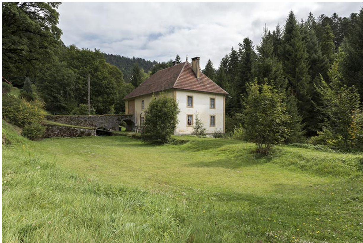
Vue d'ensemble depuis le nord-ouest, avec l'ancien bassin de retenue au premier plan. 25, Montlebon
