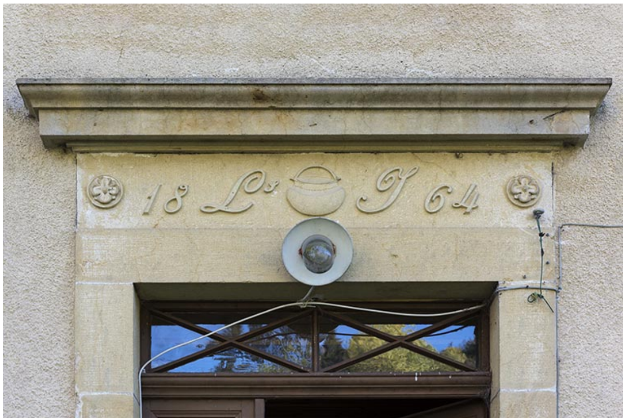
Façade antérieure : linteau sculpté et daté 1864.
