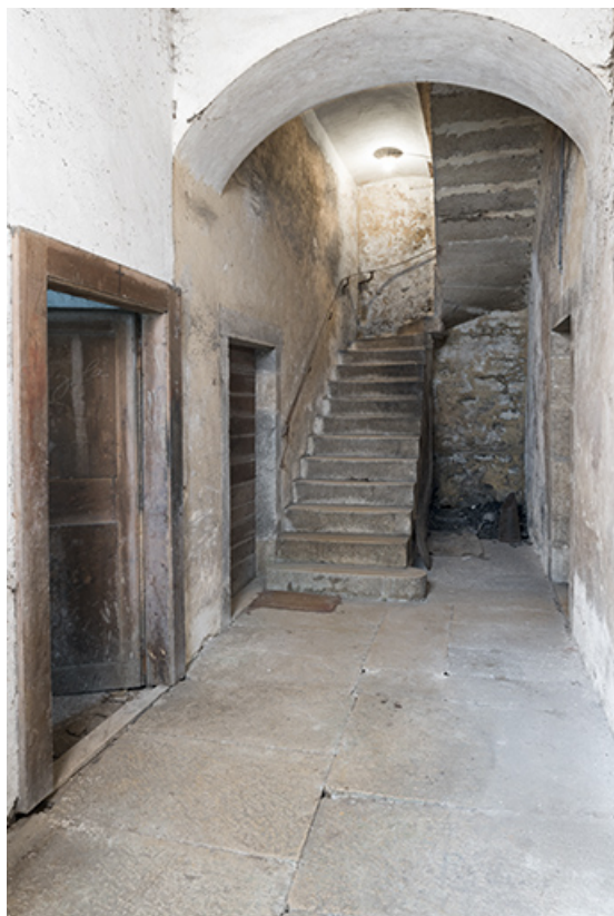
Escalier et couloir, à l'étage de soubassement.
