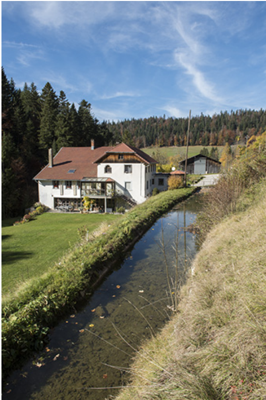
Vue d'ensemble plongeante sur le bâtiment et le bassin de retenue, depuis le sud-est. 25, Montlebon, lieudit : Derrière le Mont
