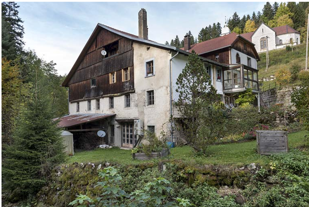
Bâtiment depuis le cours d'eau, au sud.
