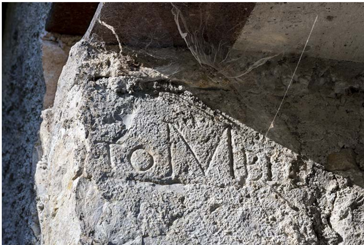
Bâtiment : inscription près de l'angle sud.
