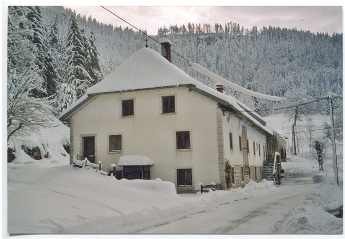
[L'usine Sauge sous la neige en mars 2003].
