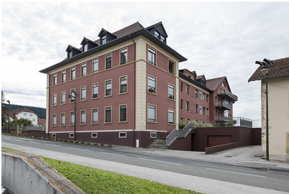
Façades antérieure et latérale gauche, depuis le nord.
