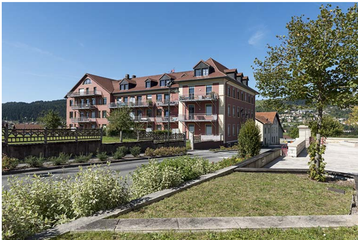
Vue d'ensemble, depuis le sud (façades postérieure et latérale gauche). 25, Montlebon, Doubs rue du 8
