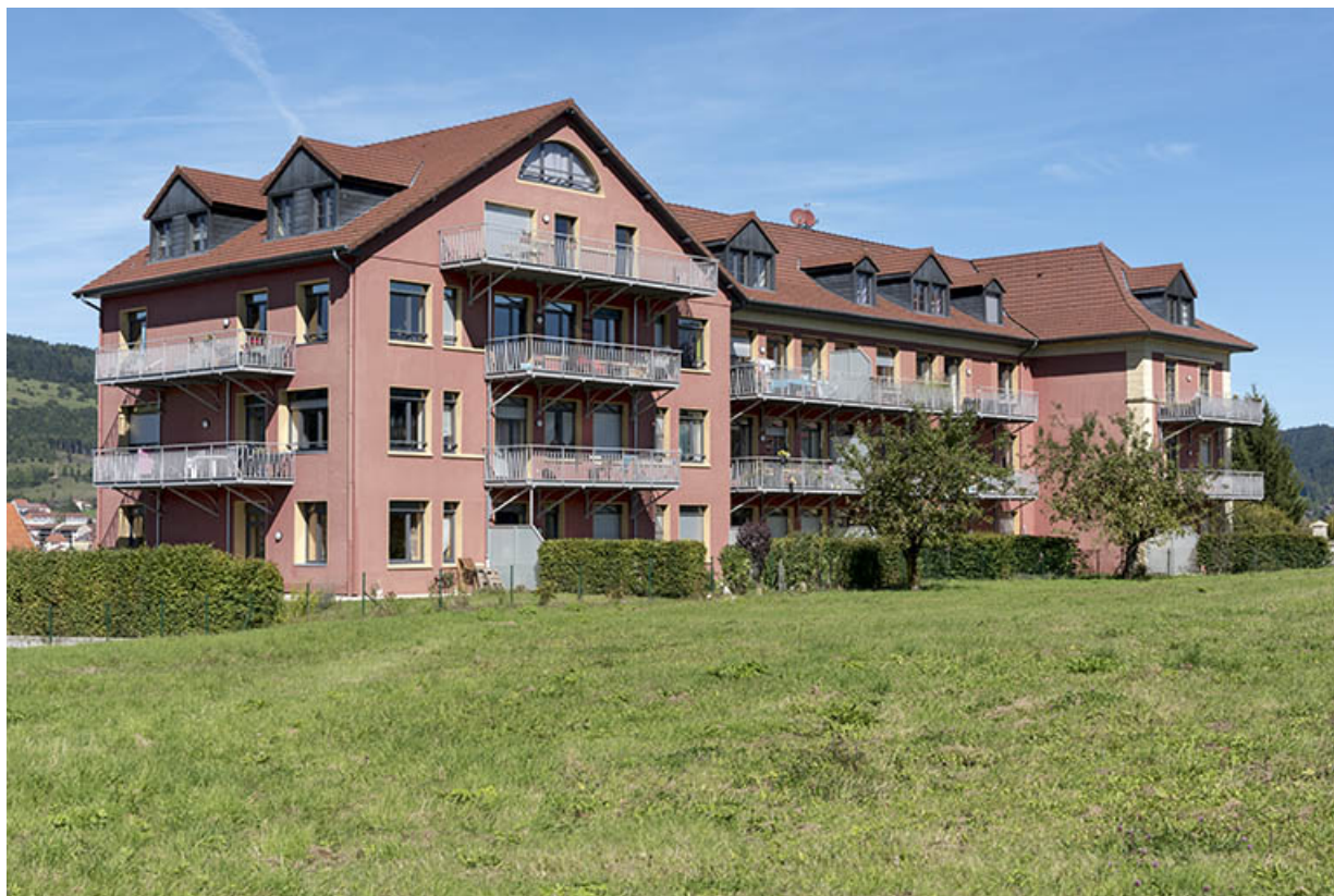
Façades postérieure et latérale droite, depuis le sud.
