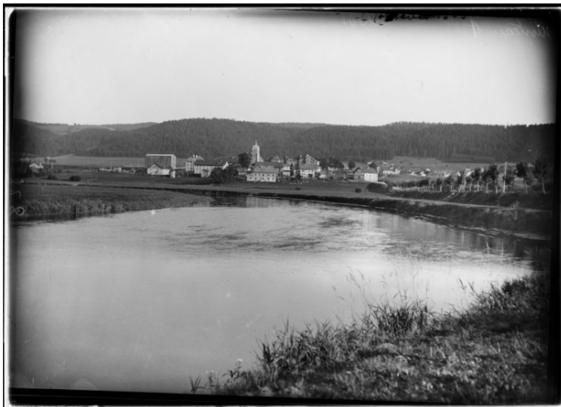
Le village et l'église paroissiale de l'Assomption vus depuis une rive du Doubs [1re moitié 20e siècle]. 25, Montlebon, Doubs rue du 8
