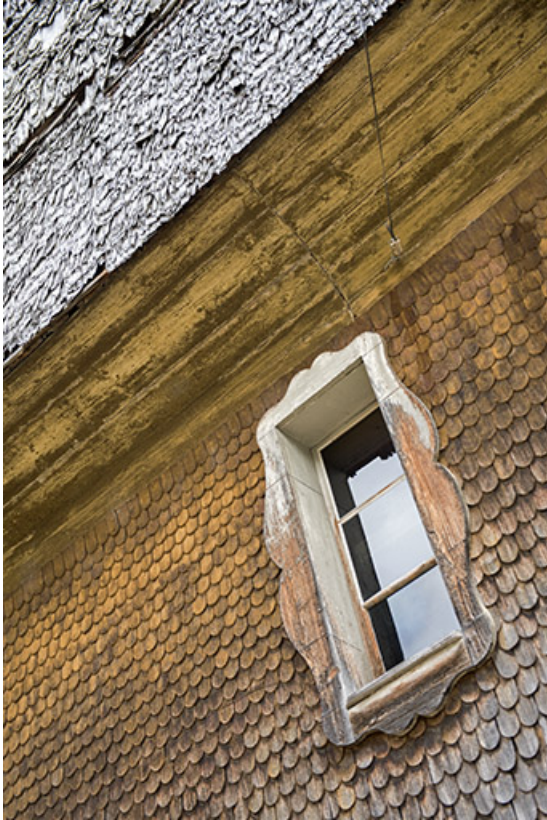
Façade latérale gauche : essentage de tavaillons et fenêtre.
