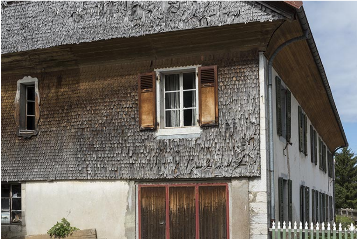
Façade latérale gauche : essentage de tavillons, avec la façade antérieure en enfilade.
