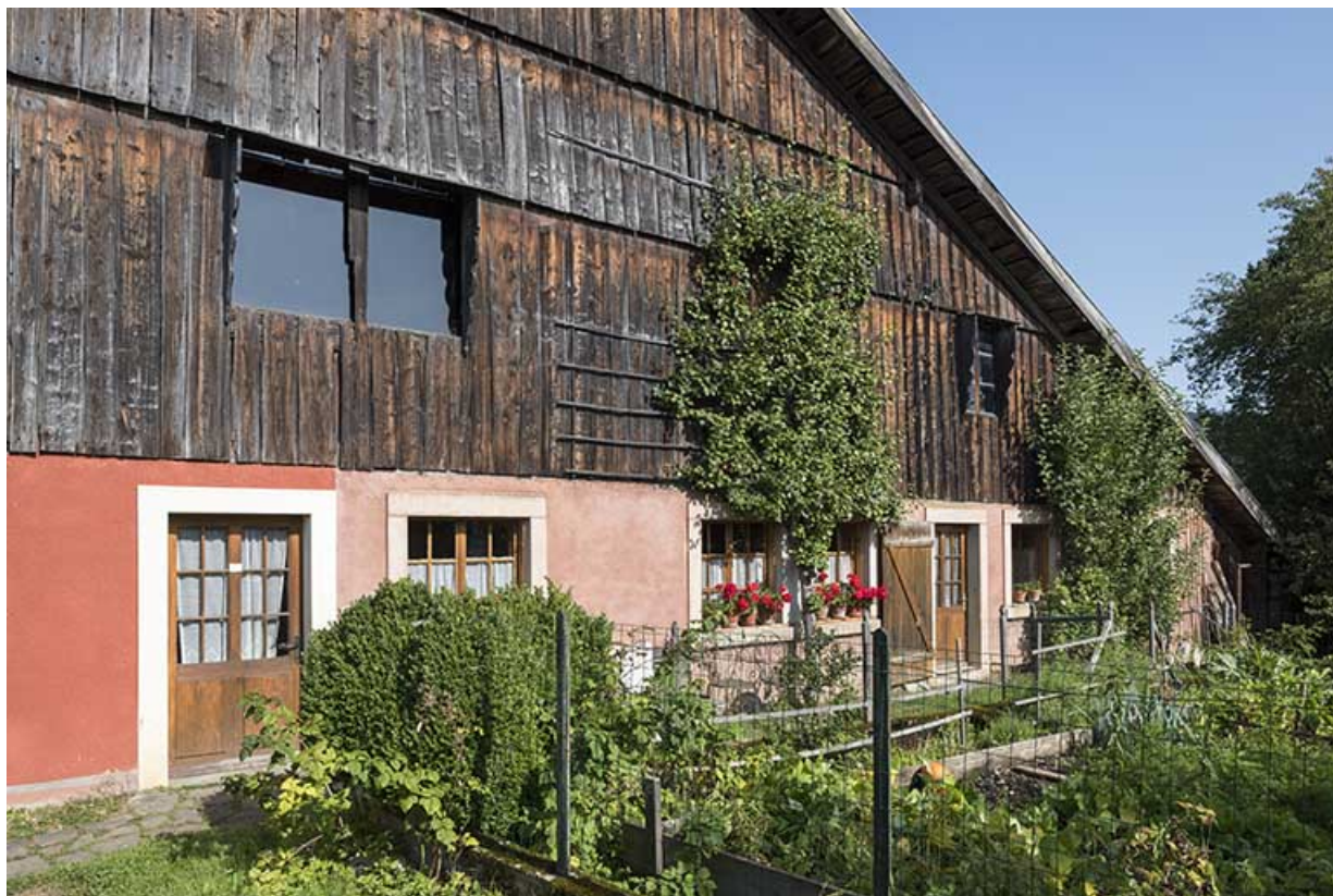
Façade antérieure : partie droite (habitation). 25, Grand'Combe-Châteleu, lieudit : les Cordiers
