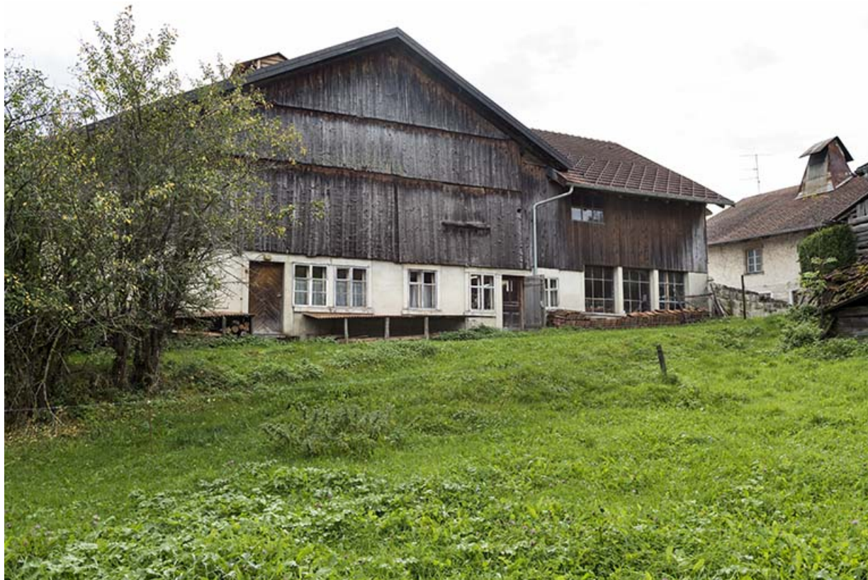
Façade postérieure : vue rapprochée avec les fenêtres de l'atelier de mécanique à droite.
