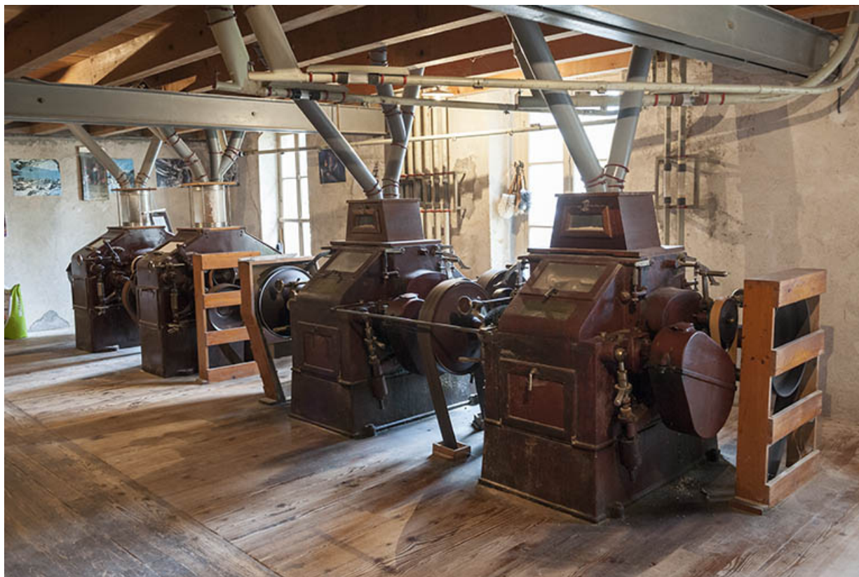
Premier étage. Appareils à cylindres (broyeurs et convertisseurs). 25, Liesle, lieudit : le Moulinot
