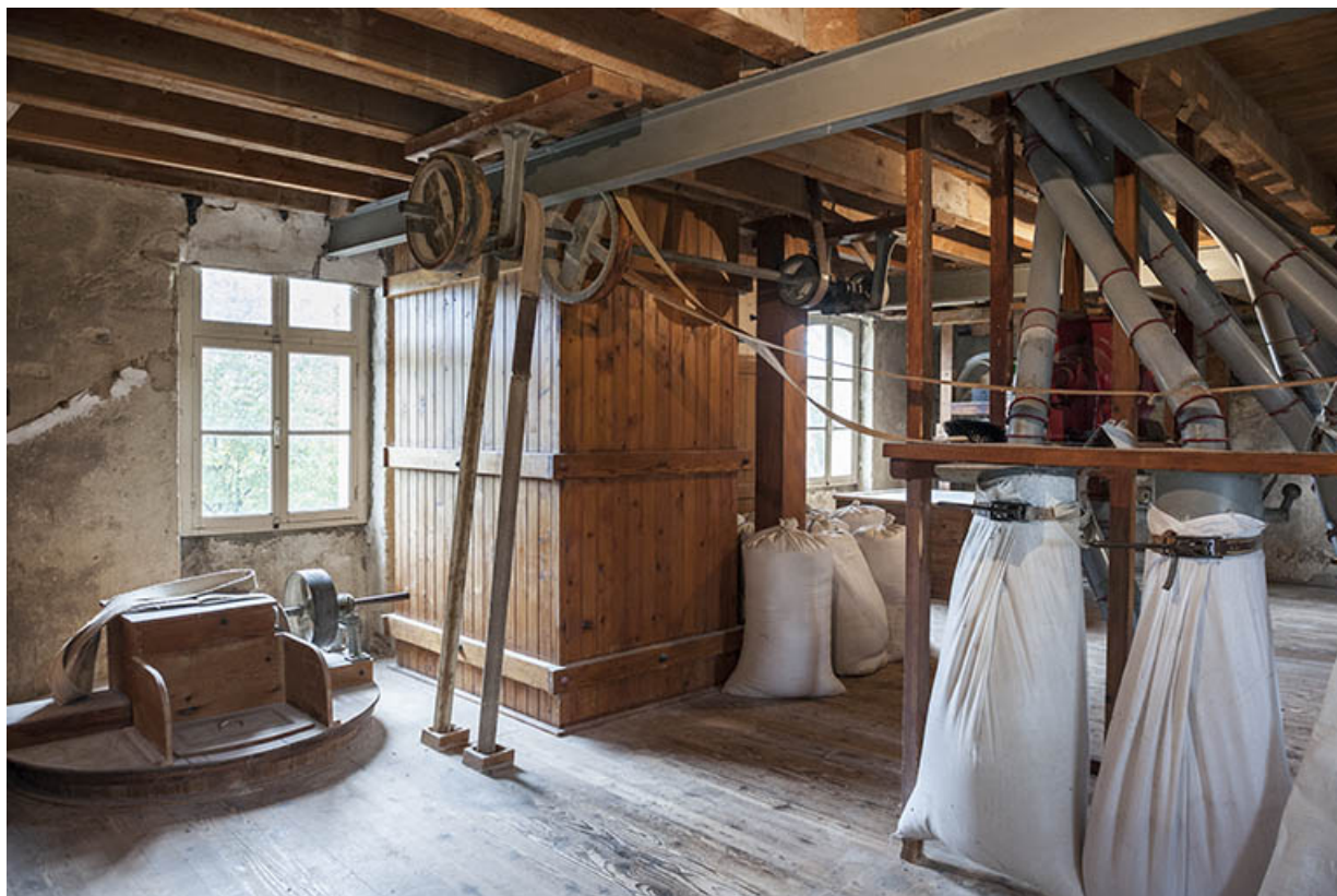
Vue d'ensemble du deuxième étage. Chambre à farine, transmission et ensachage. 25, Liesle, lieudit : le Moulinot
