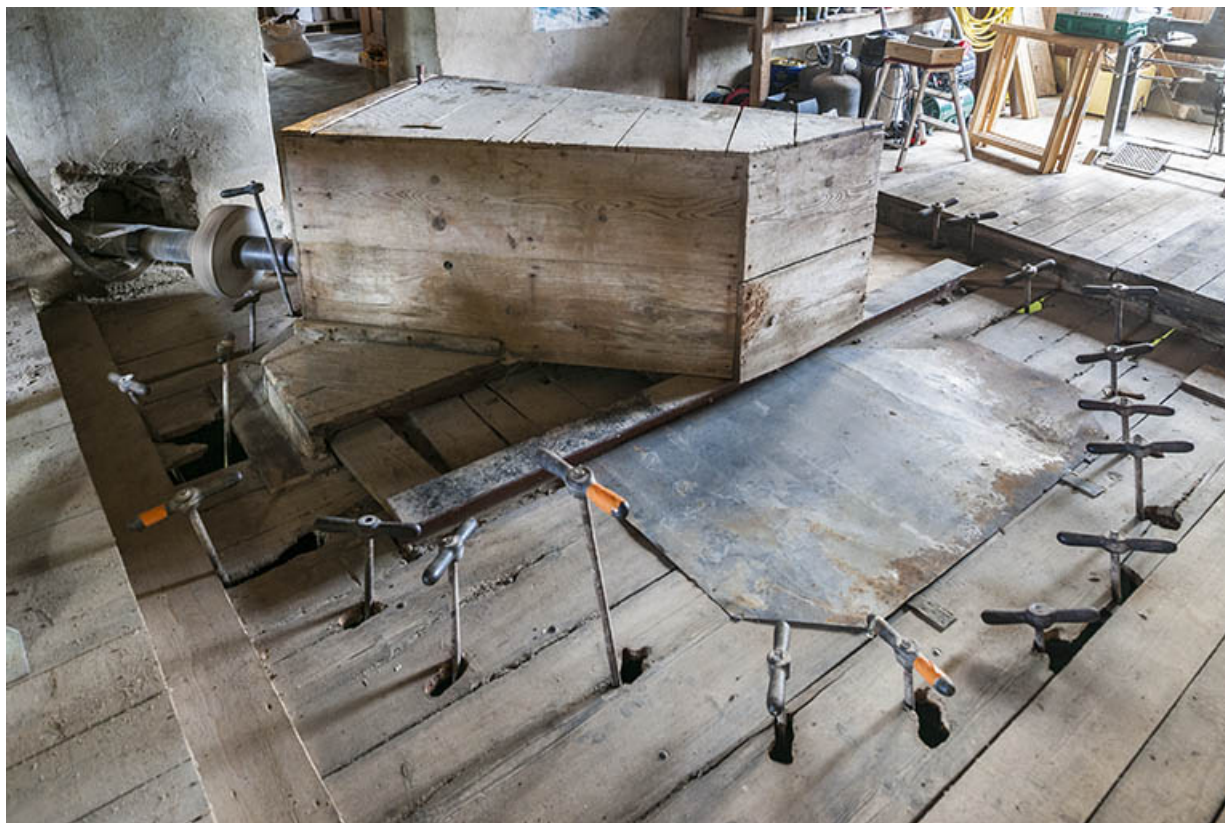
Poignées de commande des pales de la turbine et coffre couvrant la transmission.
