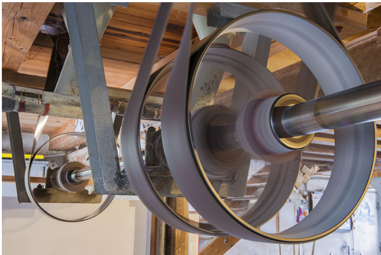
Rez-de-chaussée. Axe, poulies et courroies.
