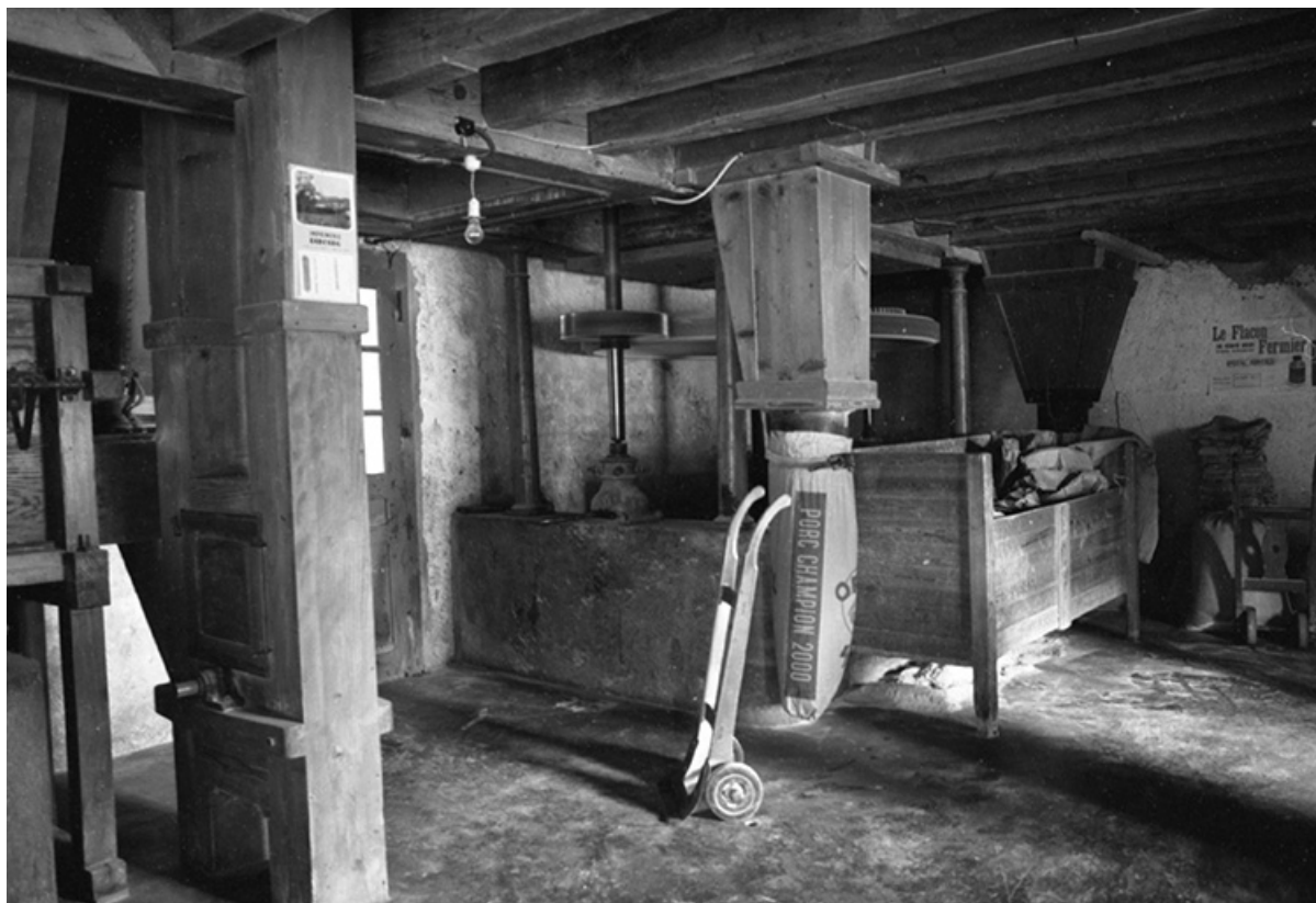
Vue intérieure : chargement des sacs.
