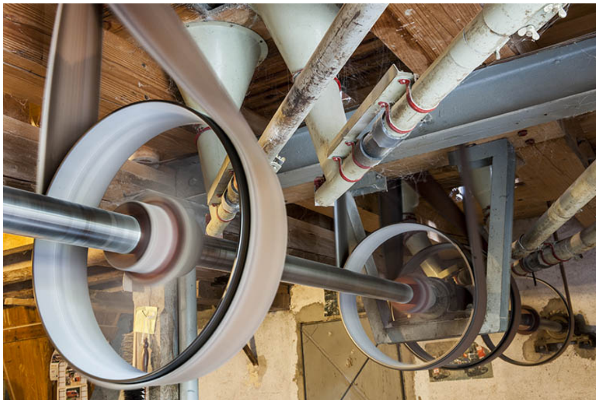
Rez-de-chaussée. Poulies et courroies en mouvement sur l'axe de transmission.
