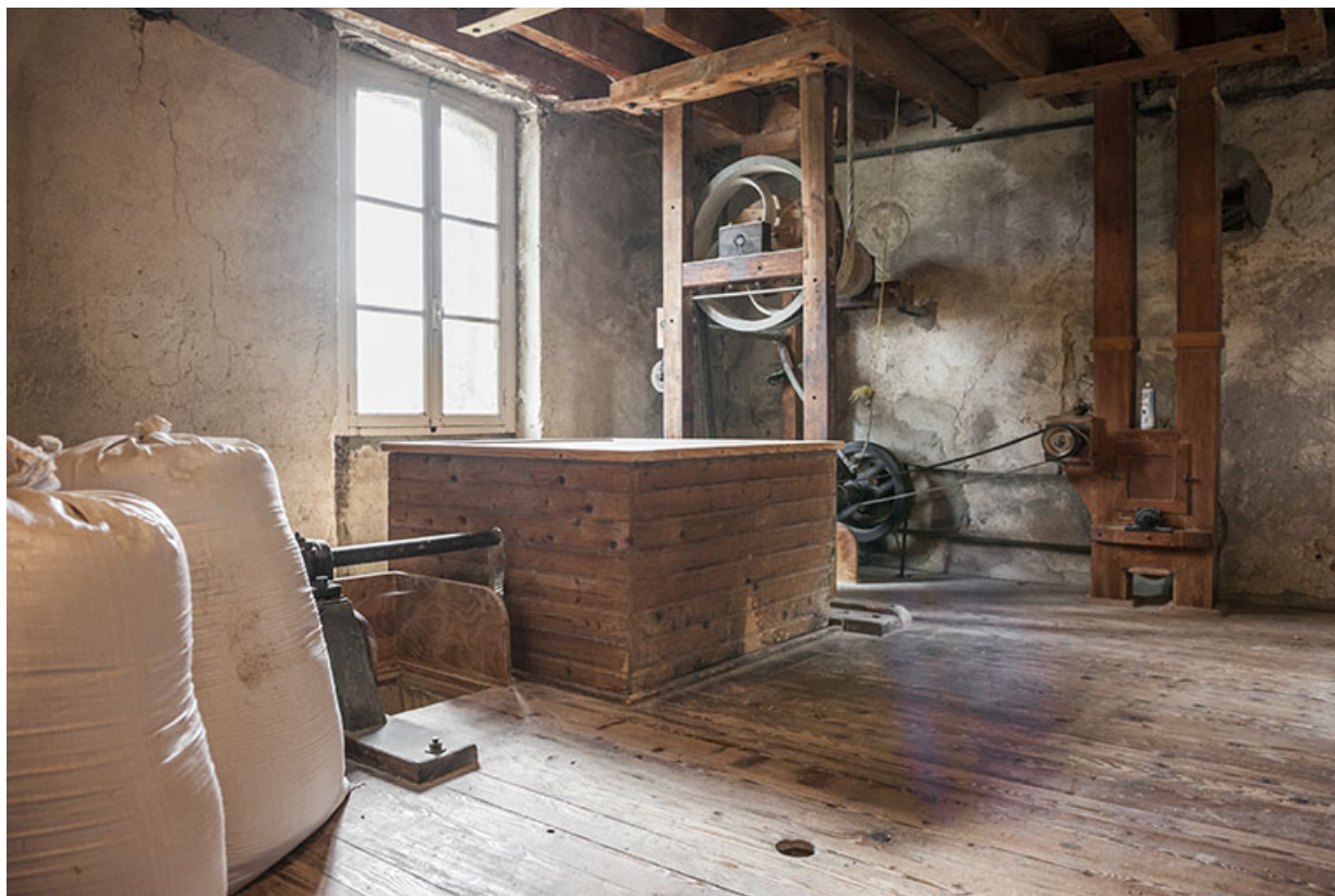
Deuxième étage. Coffre protégeant la transmission mécanique.
