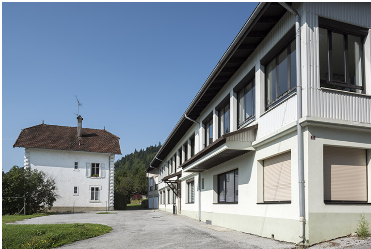
Façade latérale droite de la maison et façade antérieure de l'usine, vue en enfilade.
