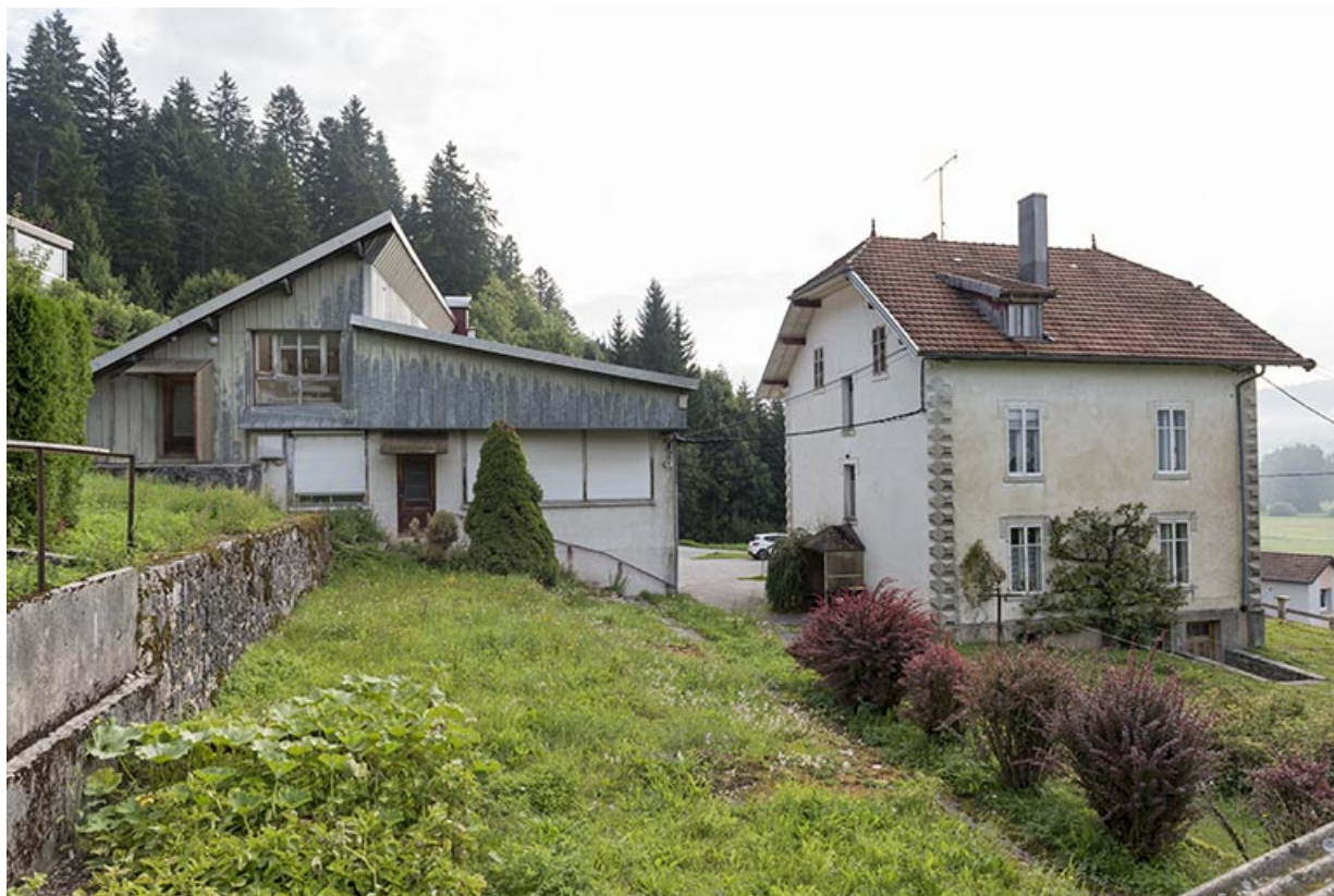
Façades latérale gauche de la maison et de l'usine. 25, Grand'Combe-Châteleu, lieudit : le Pont de la Roche
