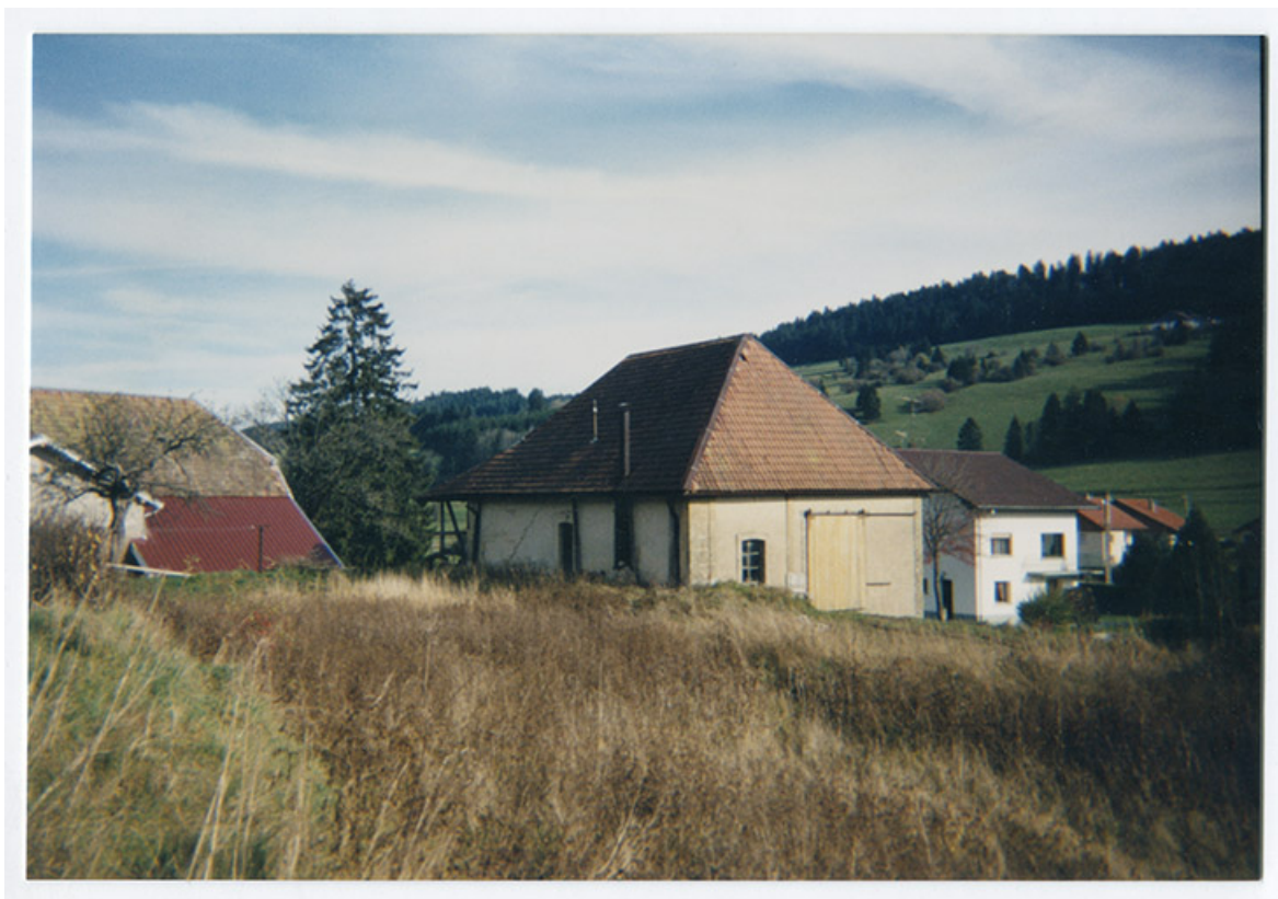
La scierie vue de l'ouest, en novembre 1994. Au premier plan, le bassin de retenue. 25, Grand'Combe-Châteleu, lieudit : les Forges
