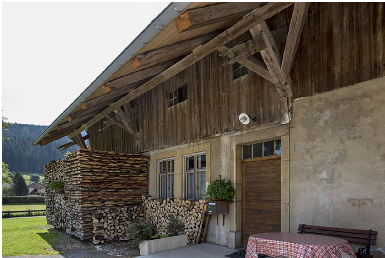
Ferme : façade latérale droite (nord), vue en enfilade.
