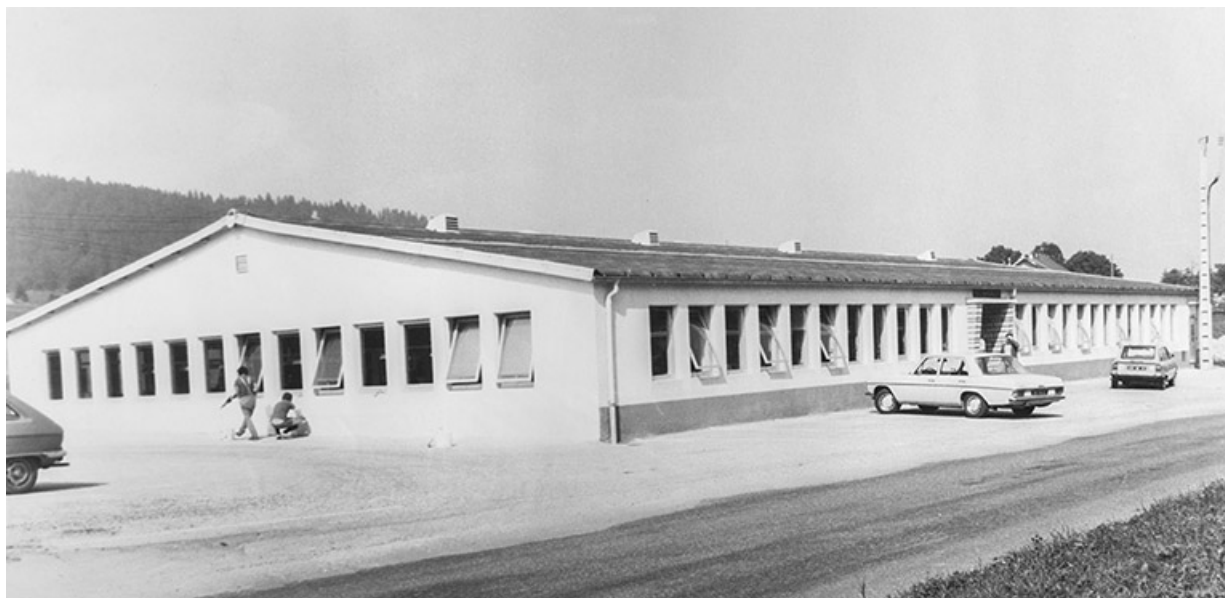
[Vue d'ensemble de l'usine avant extension], entre 1972 et 1989.
