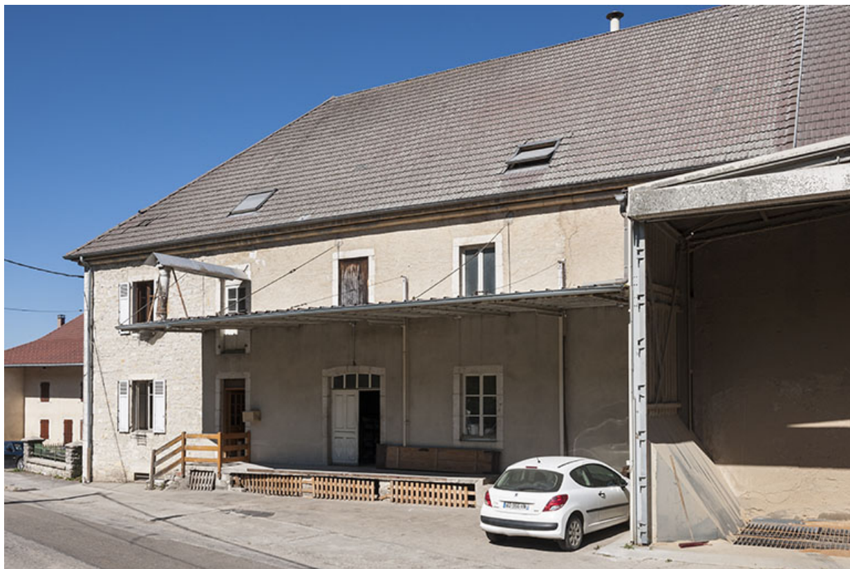
Façade sud-est de la minoterie.
