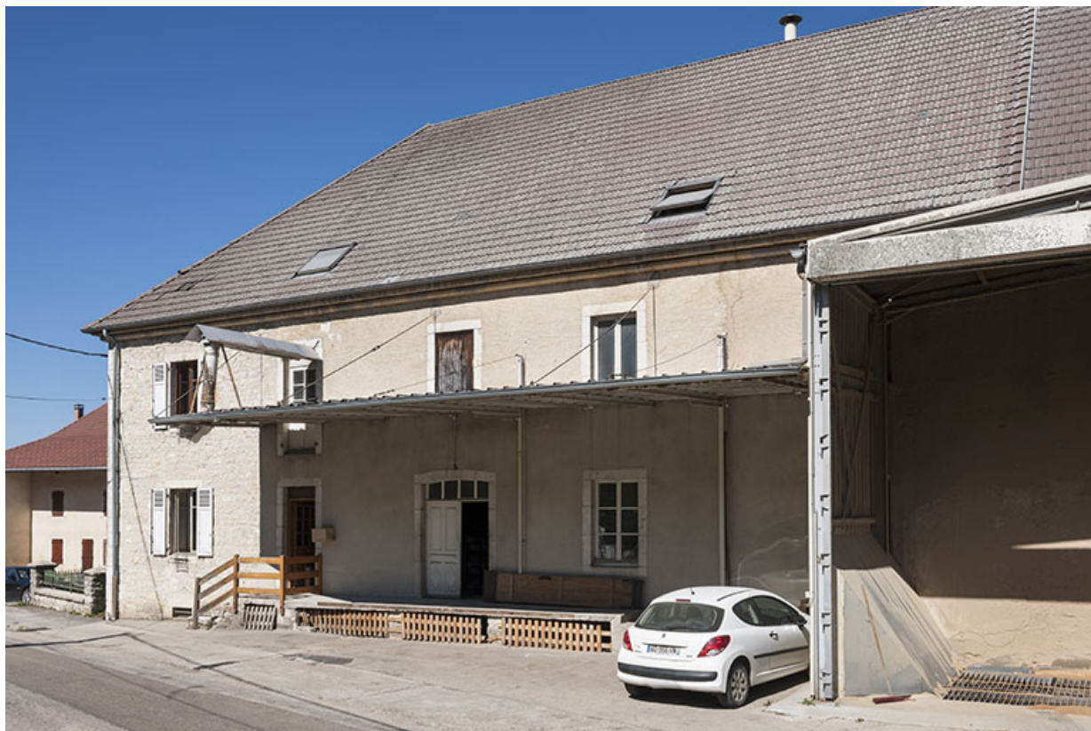
Façade sud-est de la minoterie.
