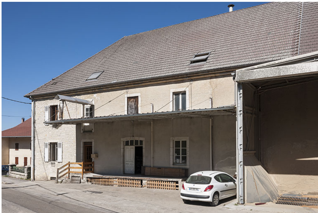
Façade sud-est de la minoterie.
