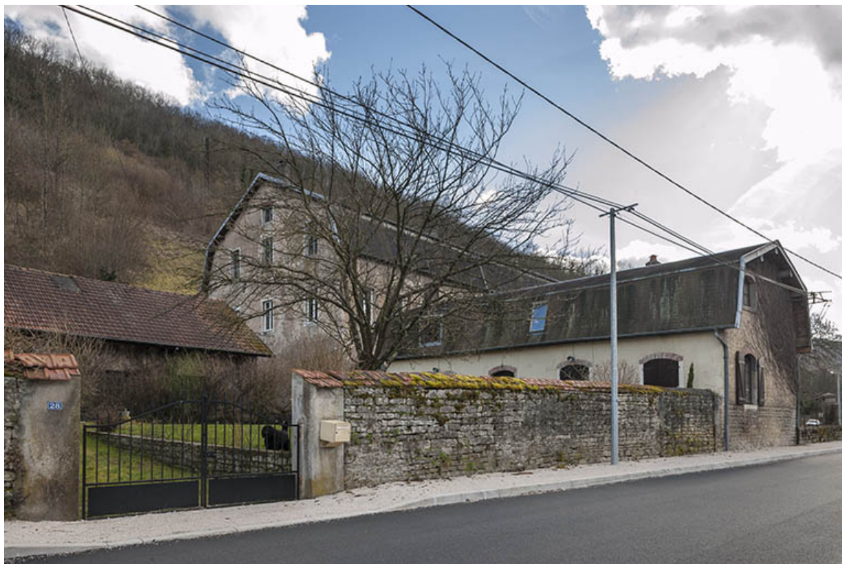
Pignon nord de l'atelier de fabrication et façade postérieure de la conciergerie.
