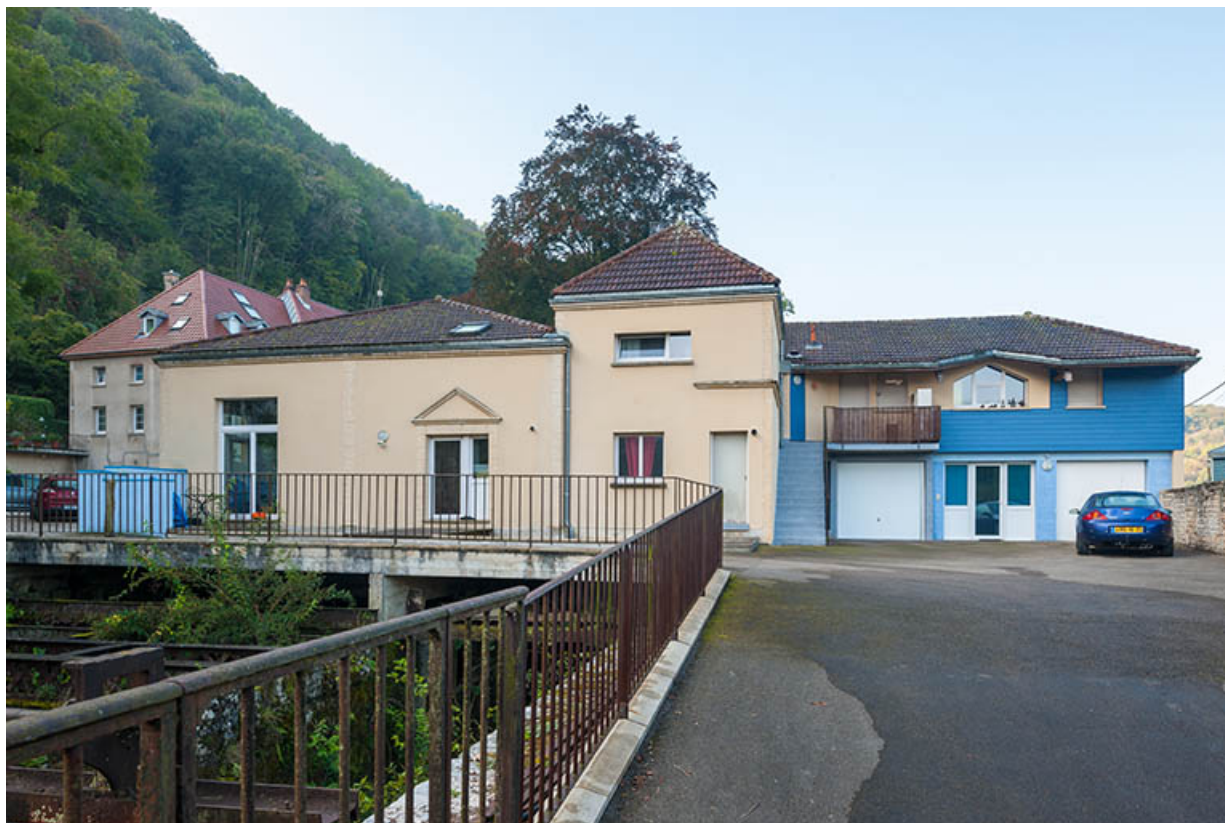
Bâtiment de la centrale hydroélectrique (remaniée), depuis l'amont. 25, Beure rue Paul Dubourg
