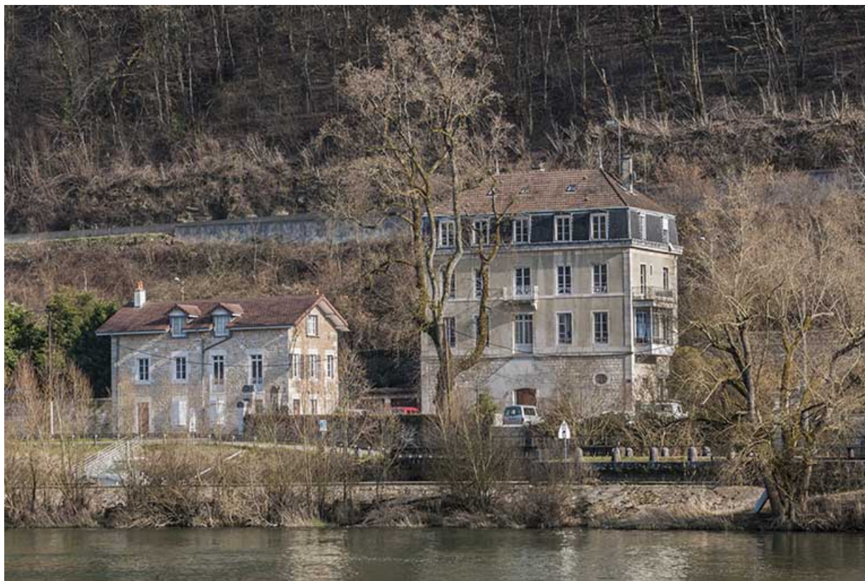
La conciergerie et le logement patronal vus depuis l'ouest.
