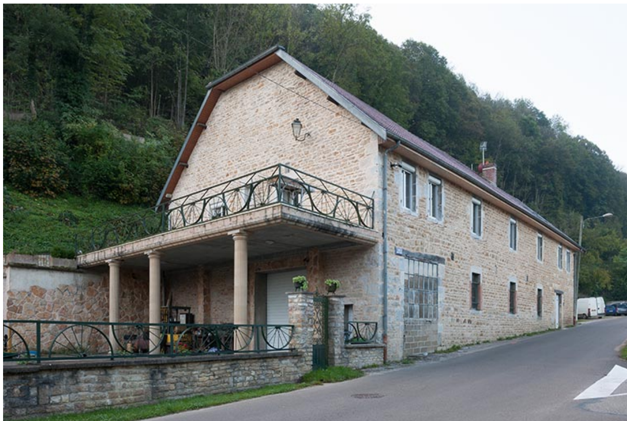
Bâtiment des logements, écuries et remises. Vue depuis le nord. 25, Beure rue Paul Dubourg
