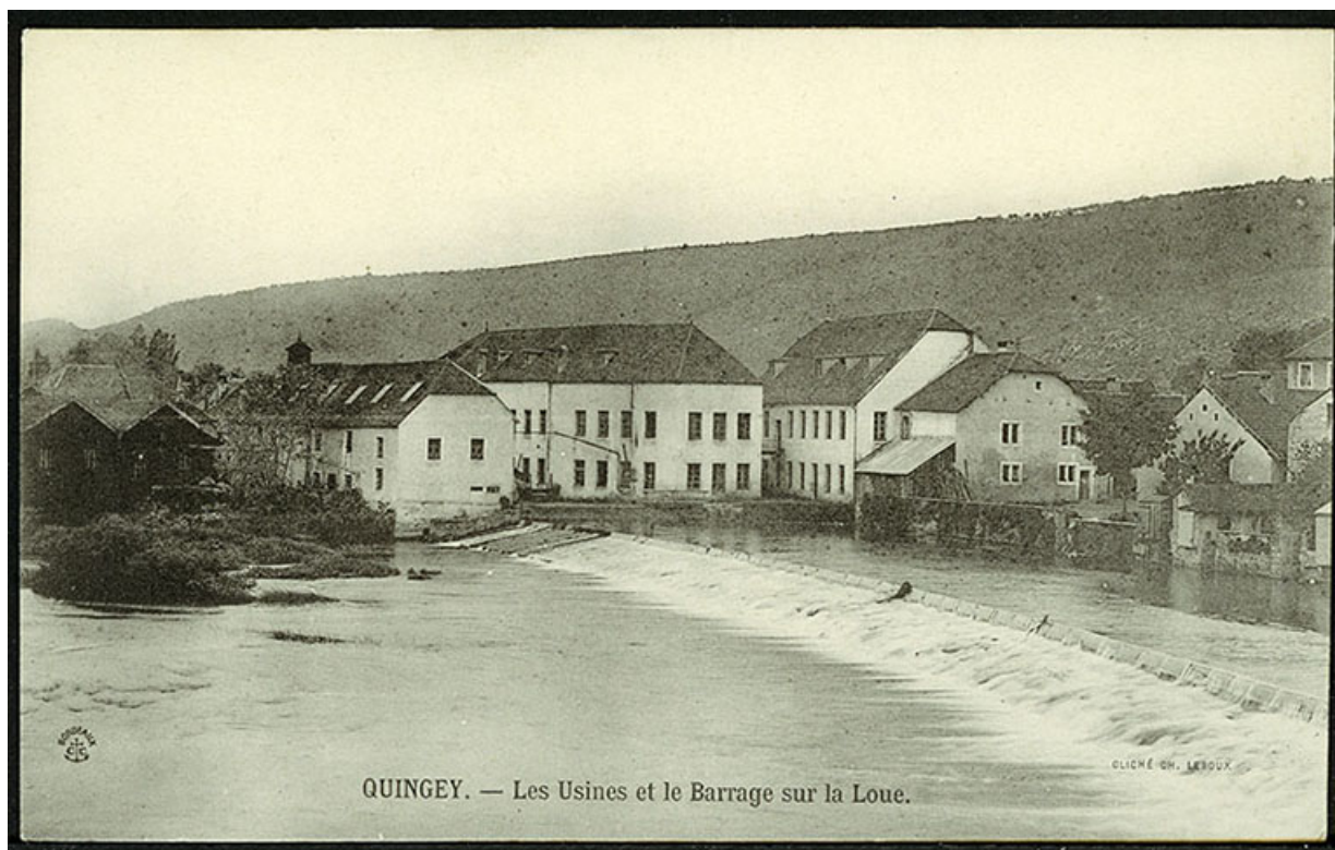
Quingey - Les usines et le barrage sur la Loue, carte postale, s.d. [fin 19e ou début 20e siècle]. 25, Quingey rue des Forges
