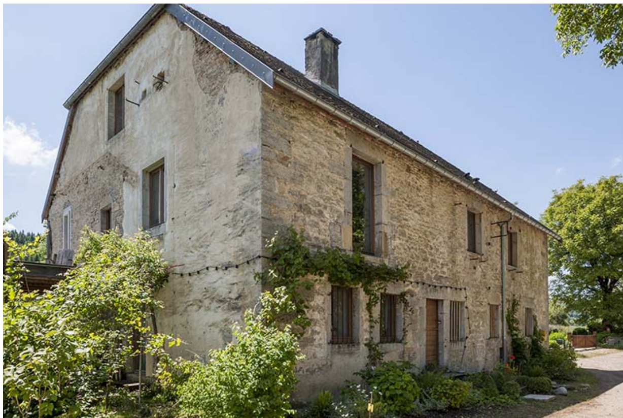
Logement d'ouvriers (puis école). Vue de trois quarts droite. 25, Châtillon-sur-Lison chemin des Forges, lieudit : les Forges
