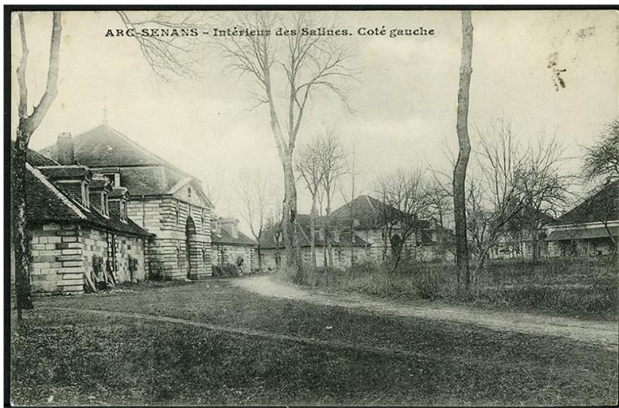
Arc-et-Senans - Intérieur des salines. Côté gauche, carte postale, s.d. [fin 19e ou début 20e siècle]. 25, Arc-et-Senans Grande Rue
