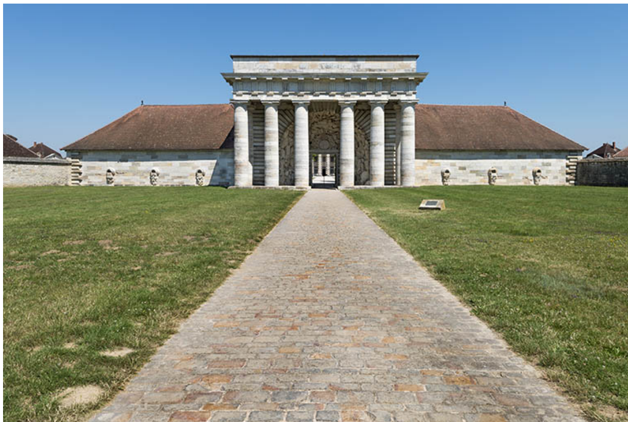
Bâtiment d'entrée. Façade sud vue de face.
