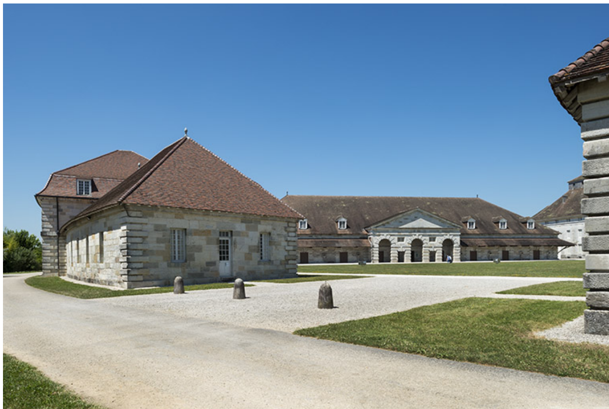
Logement d'ouvriers et berne ouest. 25, Arc-et-Senans Grande Rue
