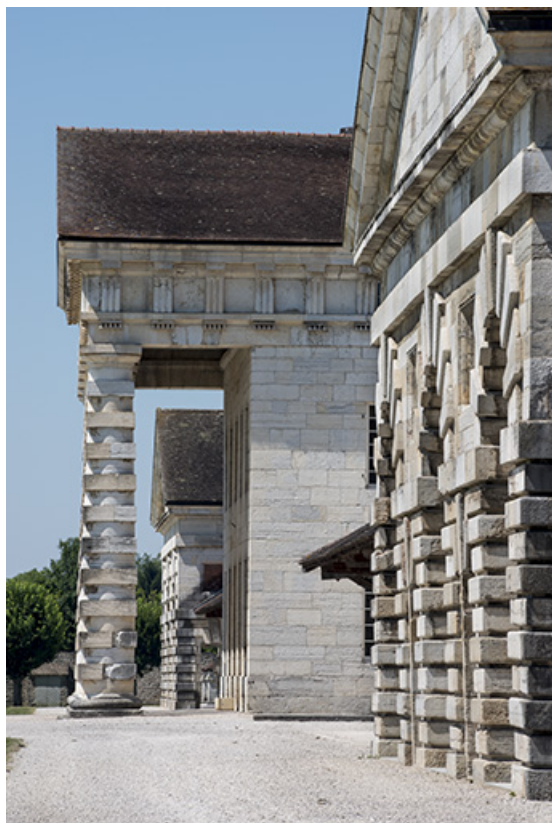
Portiques des bernes et de la maison du directeur. 25, Arc-et-Senans Grande Rue
