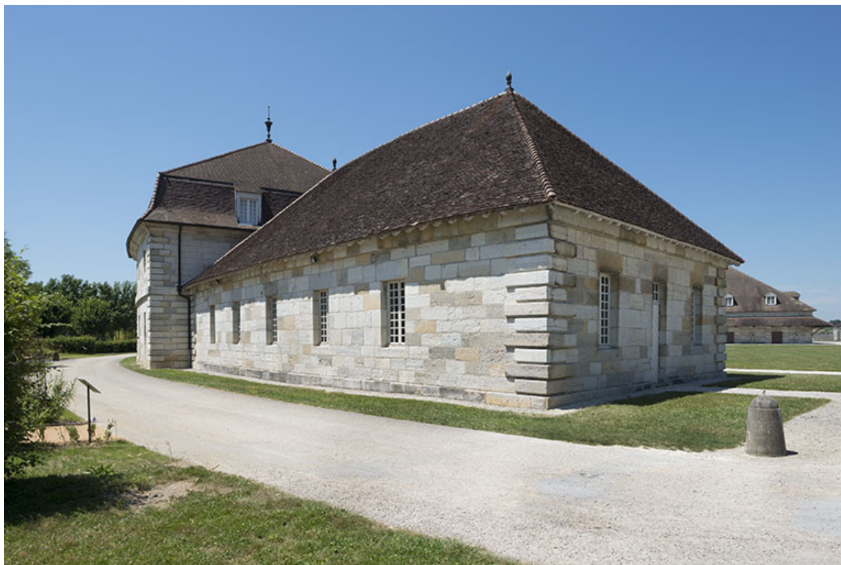
Tonnellerie vue de trois quarts arrière.
