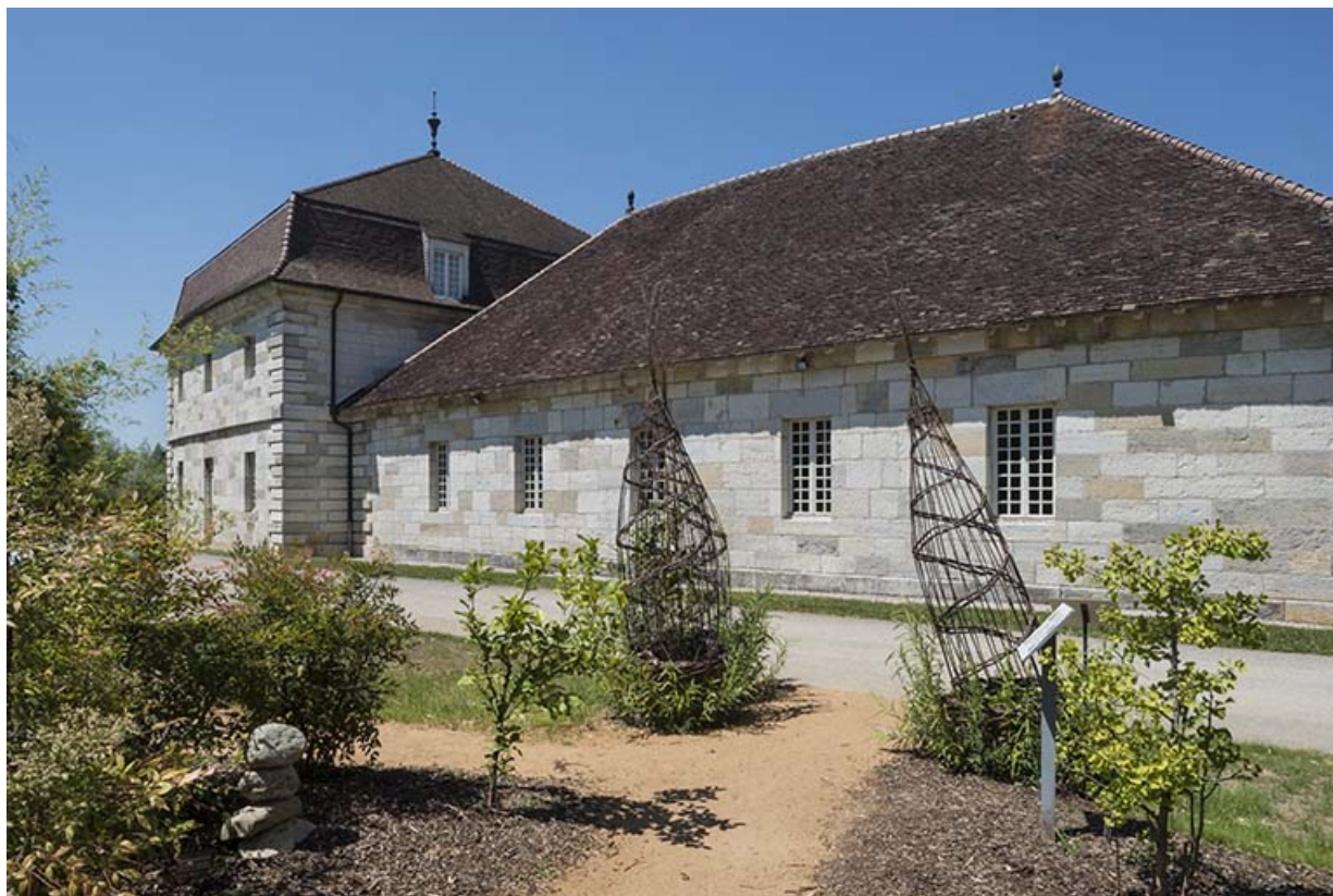
Façade postérieure de la tonnellerie.
