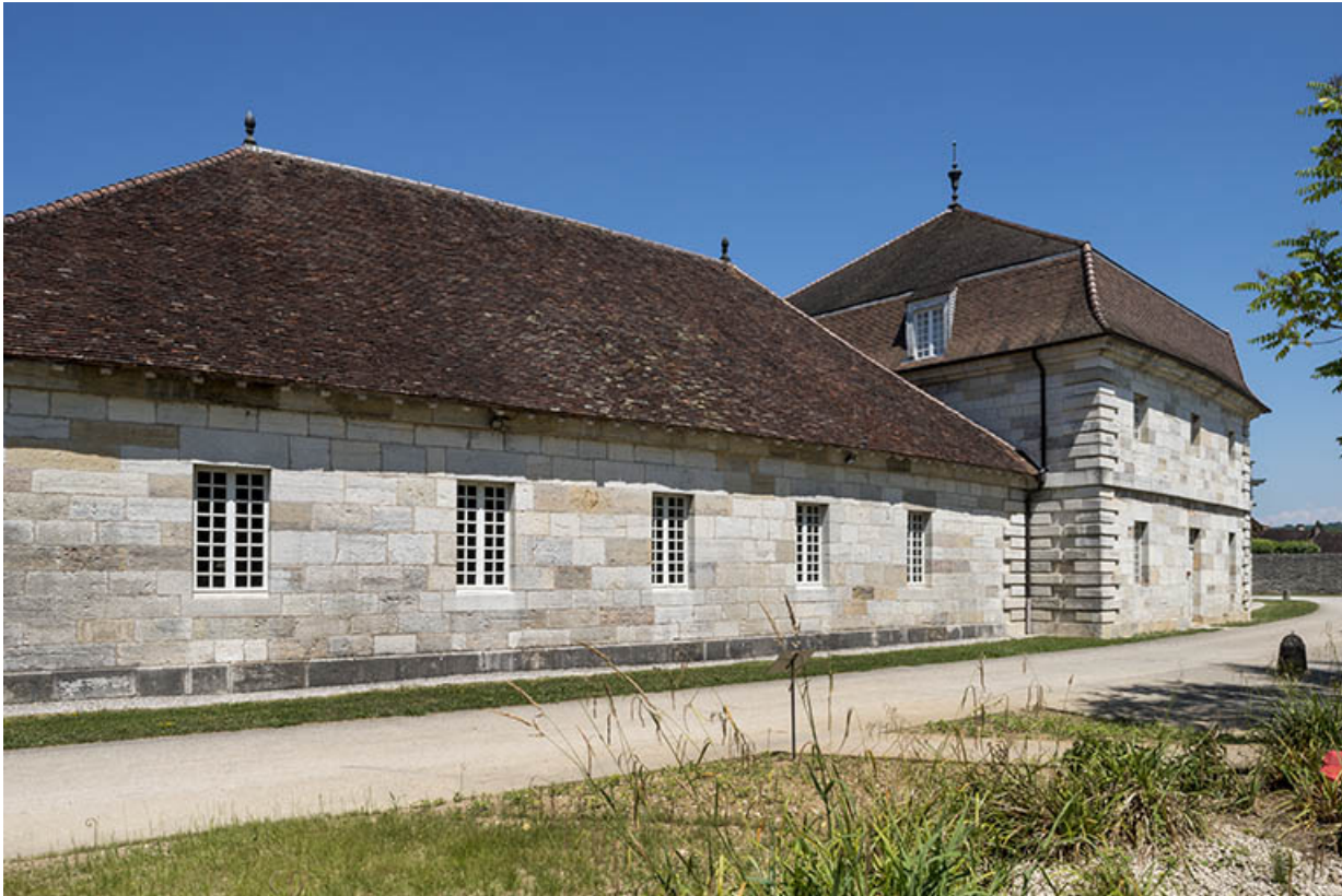
Façade postérieure de l'aile ouest de la tonnellerie.
