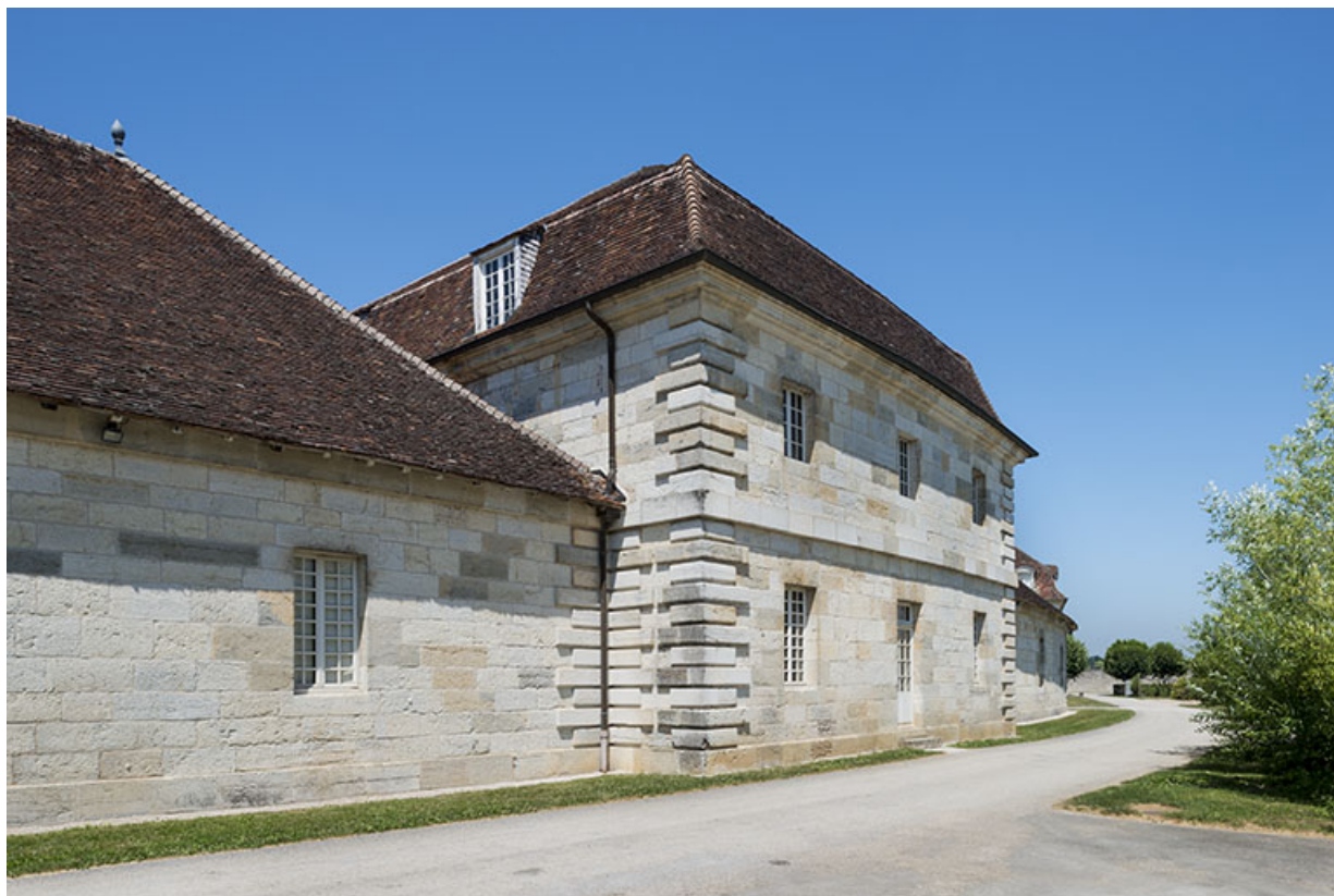
Façade postérieure du logements des ouvriers ouest.
