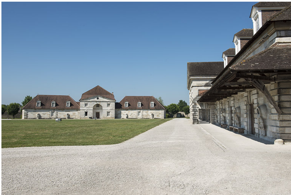
Logement des ouvriers et berne ouest. 25, Arc-et-Senans Grande Rue
