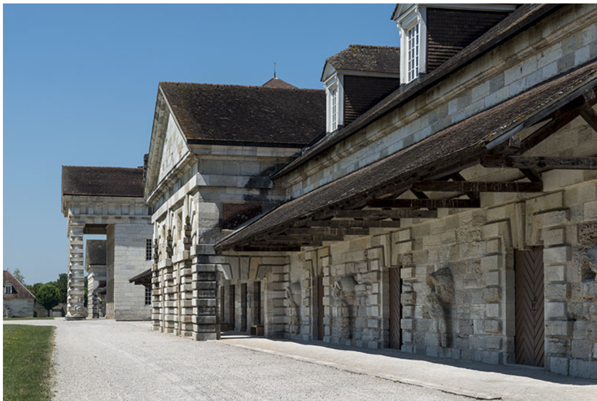
Façade antérieure de la berne est. 25, Arc-et-Senans Grande Rue
