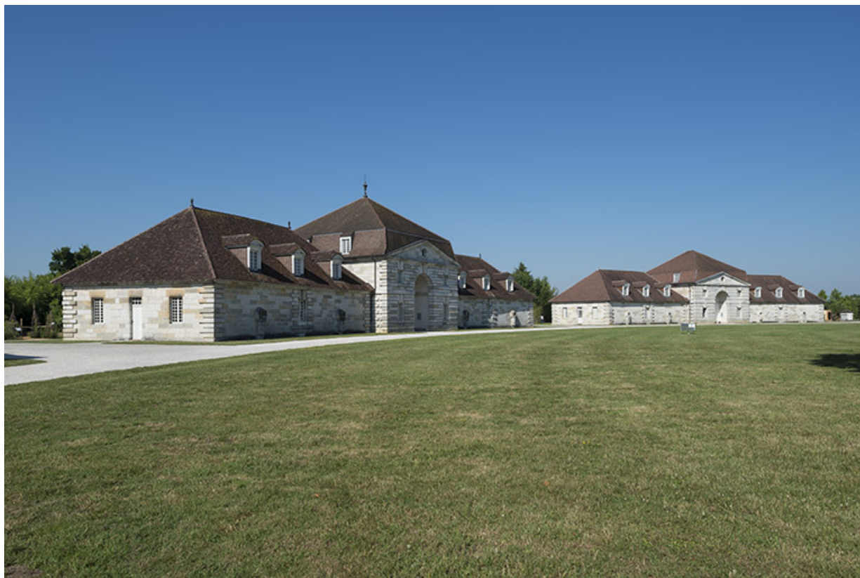
Tonnellerie (atelier et logements) et logement des ouvriers (berniers) ouest. 25, Arc-et-Senans Grande Rue
