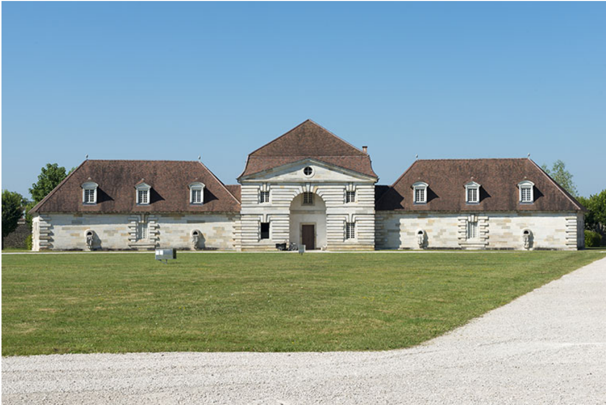
Logement des ouvriers (berniers) ouest. Vue de face. 25, Arc-et-Senans Grande Rue
