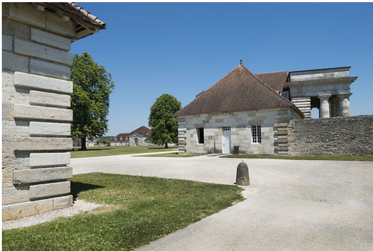
Bâtiment d'entrée vu de côté. 25, Arc-et-Senans Grande Rue
