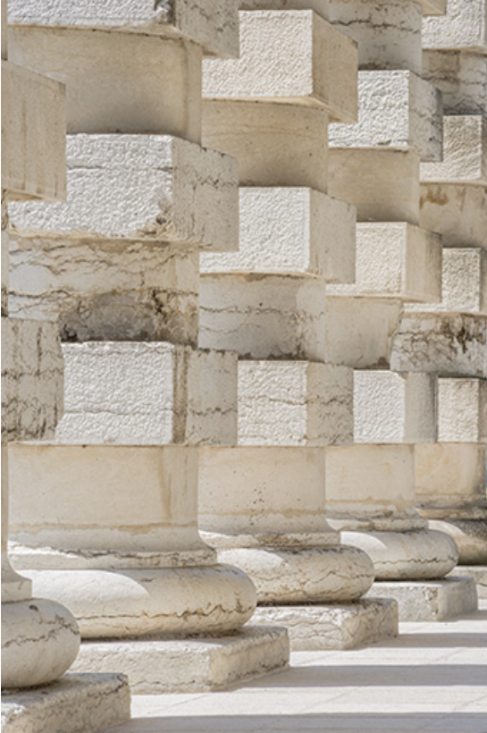
Maison du directeur. Détail de la colonnade. 25, Arc-et-Senans Grande Rue
