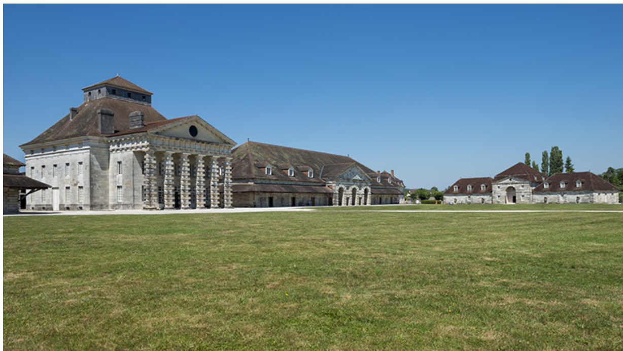
Maison du directeur, berne et logements d'ouvriers est. 25, Arc-et-Senans Grande Rue
