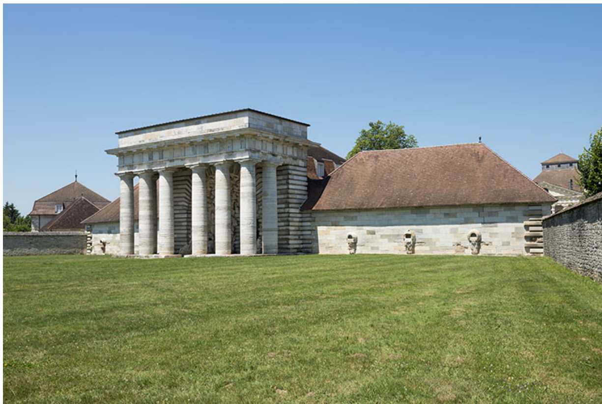
Bâtiment d'entrée. Vue de trois quarts droite.
