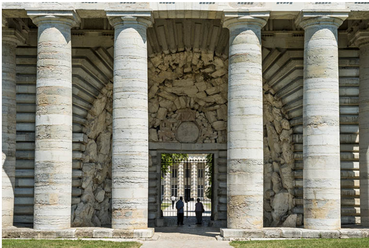
Vue rapprochée du portique et de l'entrée.
