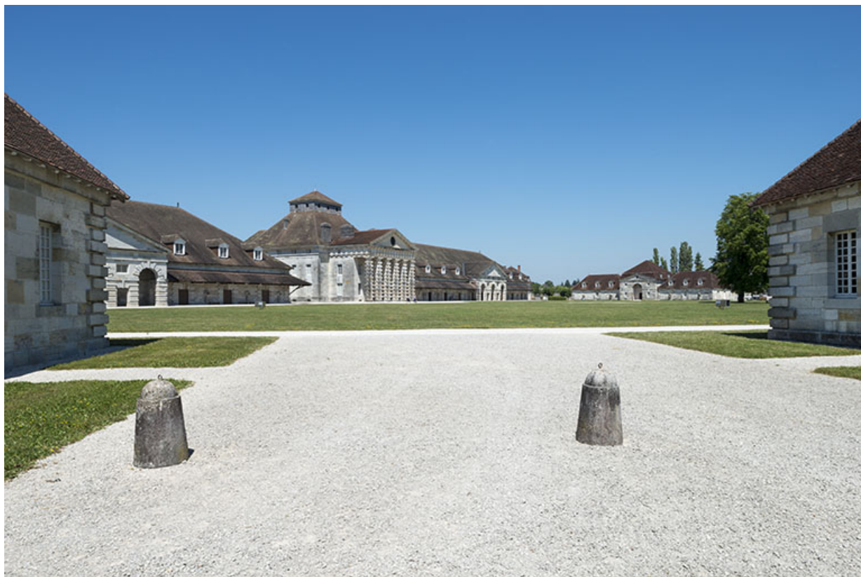
Vue d'ensemble depuis le mur sud.
