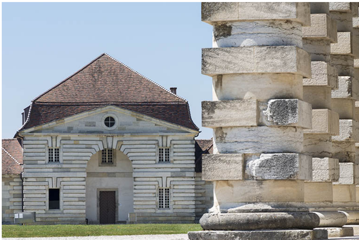
Pavillon du logement des ouvriers (berniers) ouest, depuis la maison du directeur. 25, Arc-et-Senans Grande Rue
