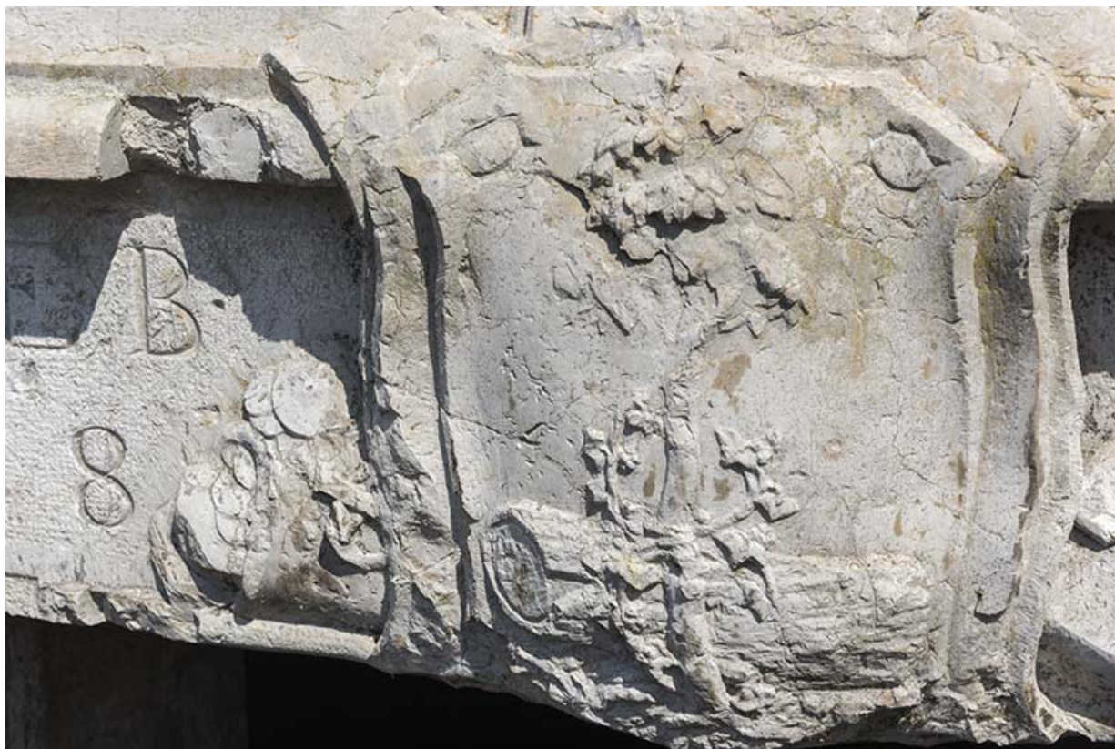
Chaudronnerie, façade antérieure : armoiries et vase sculptés sur le linteau.
