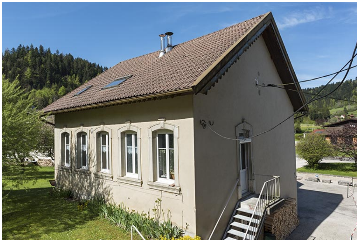
Maison : façades postérieure et latérale gauche.
