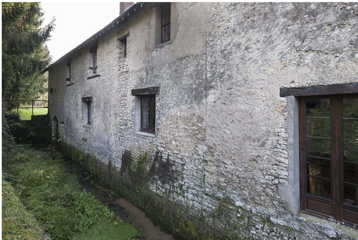
Façade est de l'atelier de forge.
