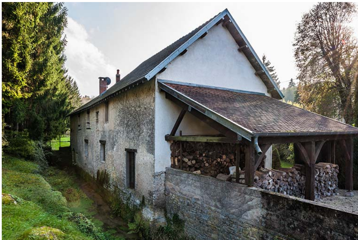
Atelier de la forge, vu de trois quarts arrière. 25, Rigney, 7, 9 rue de la Forge
