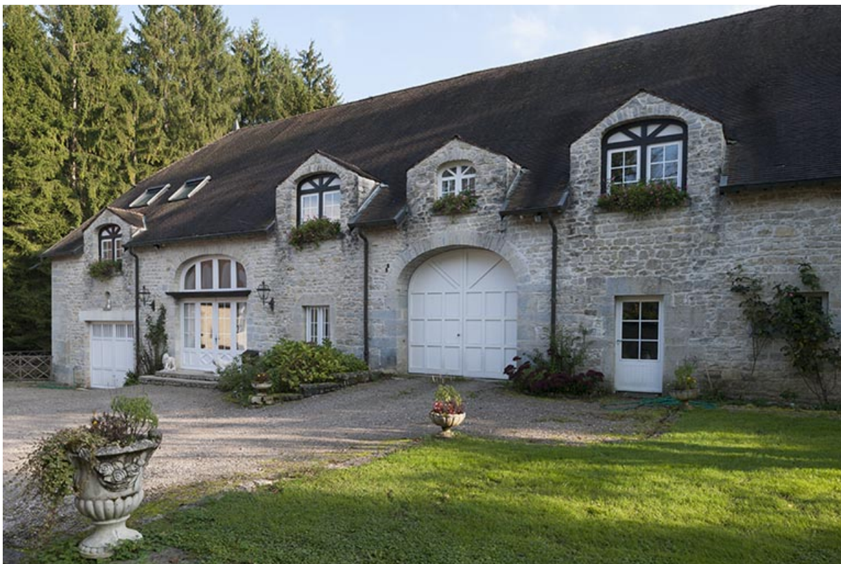
Façade nord du moulin, vue de trois quarts.
