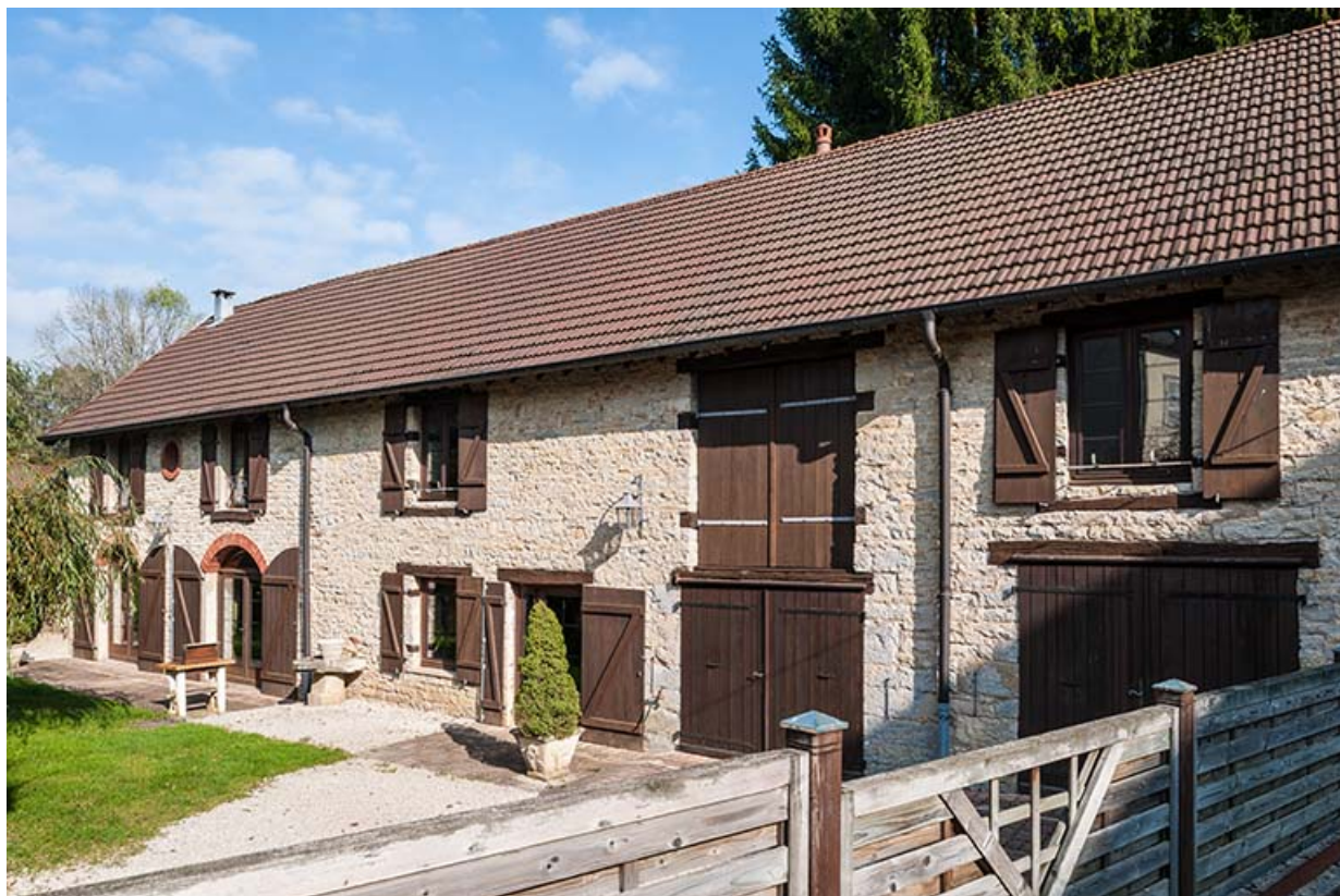
Bâtiment de la forge. Façade ouest.
