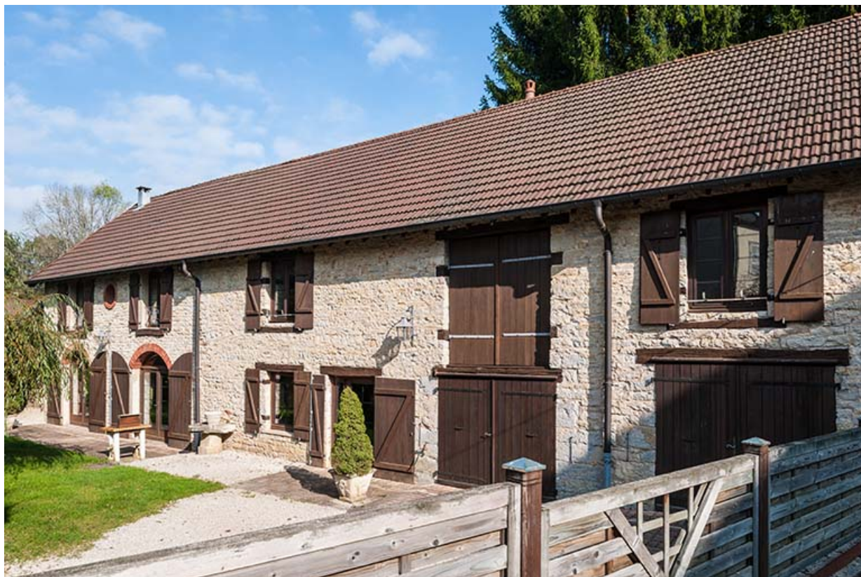
Bâtiment de la forge. Façade ouest.
