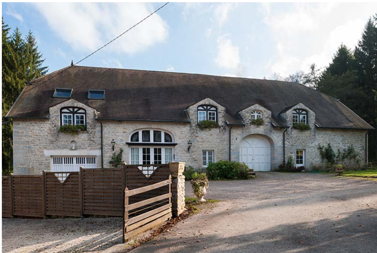
Bâtiment du moulin. Façade nord.
