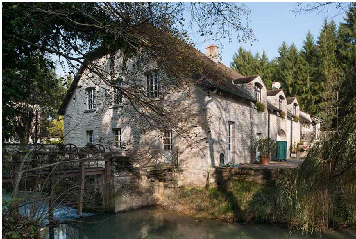
Bâtiment du moulin. Vue de trois quarts arrière.
