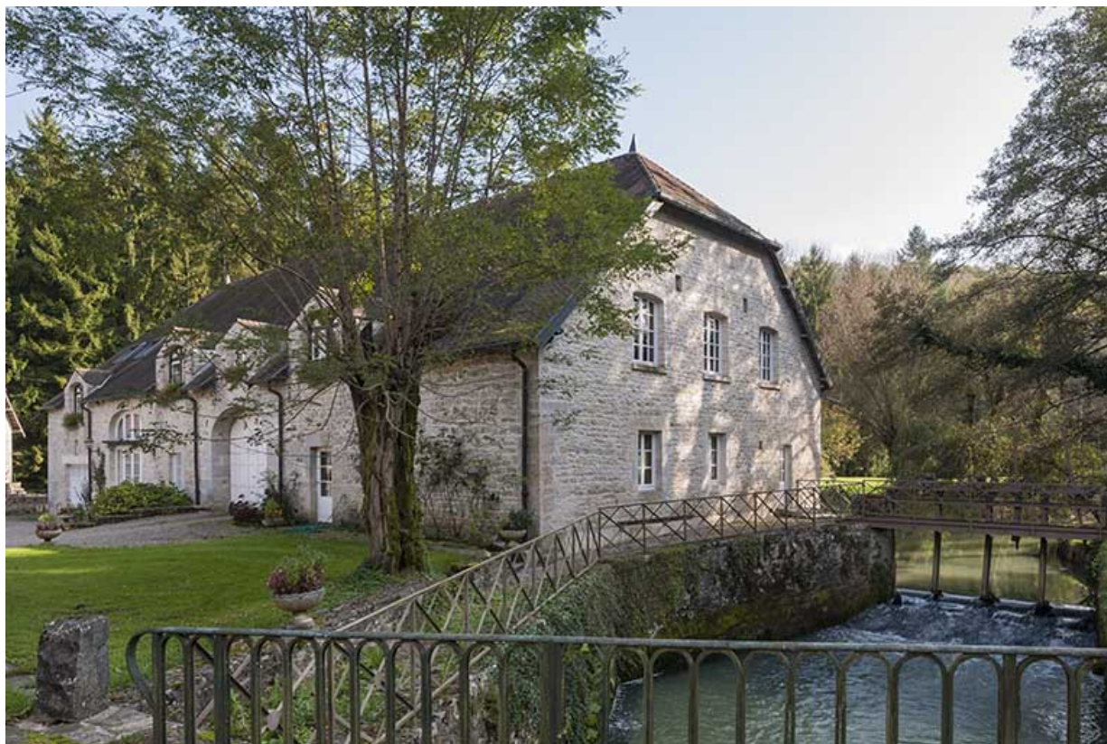
Le bâtiment du moulin et le vannage sur la Corcelle.
