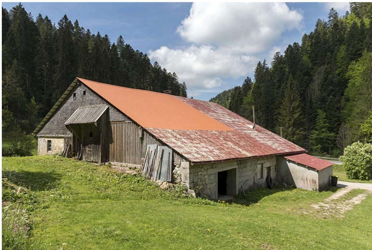
Vue d'ensemble, depuis le nord-ouest (façades postérieure et latérale gauche).
