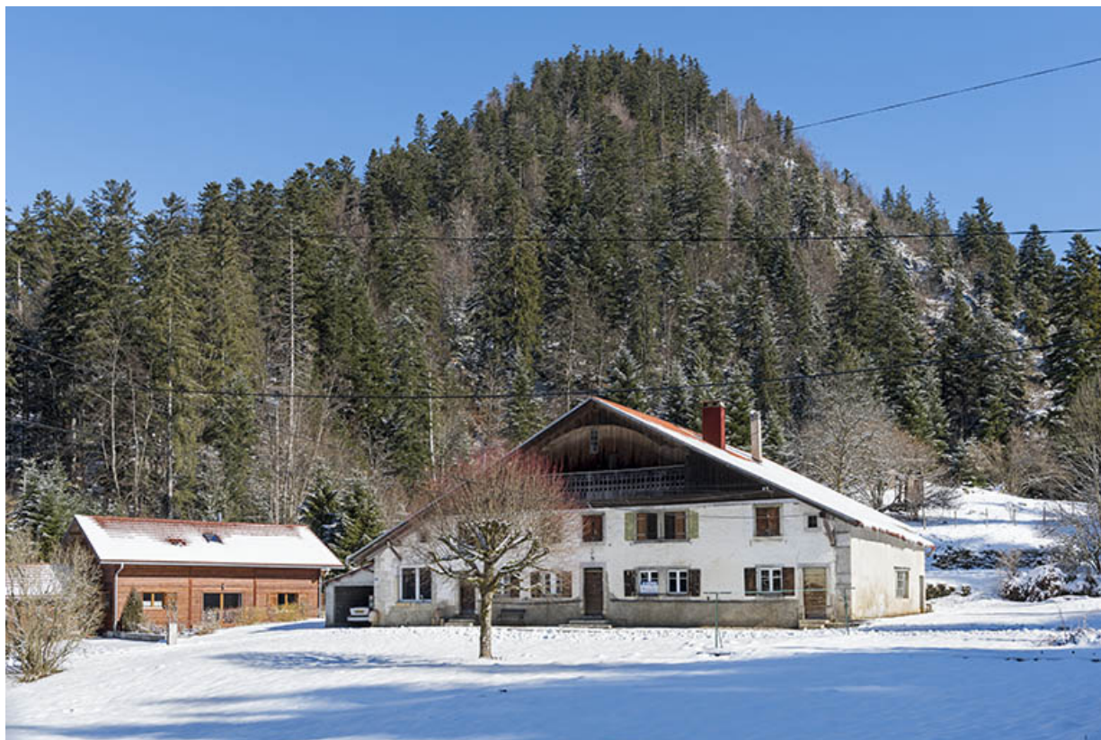
Vue d'ensemble, depuis l'ouest, en hiver.
