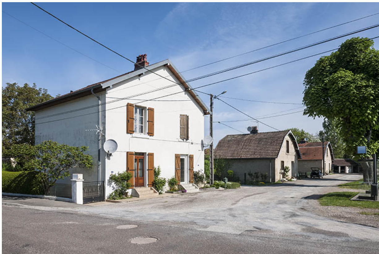
Logements ouvriers (4 à 10 allée des Rompeux). 25, Geneuille, 20 chemin des Salines
