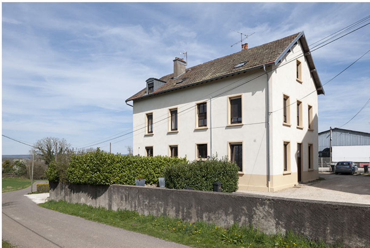
Logements (ancien bâtiment des contributions indirectes).
