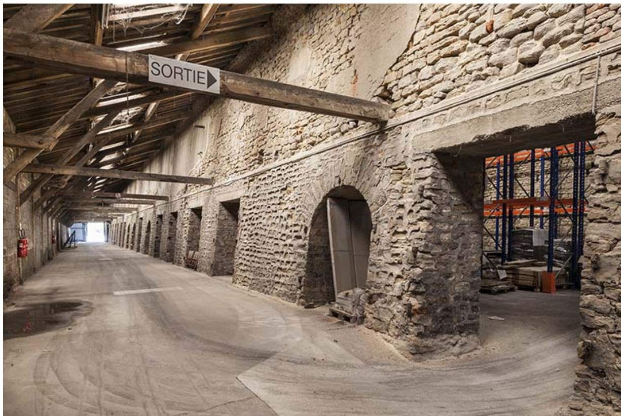
Ancien quai de chargement.
